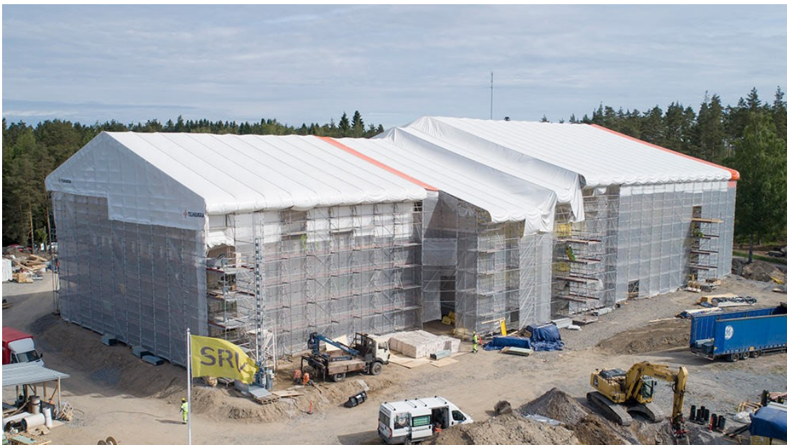
KUVA 6. Rakennuskohde suojattu sääsuojaalla (17)
