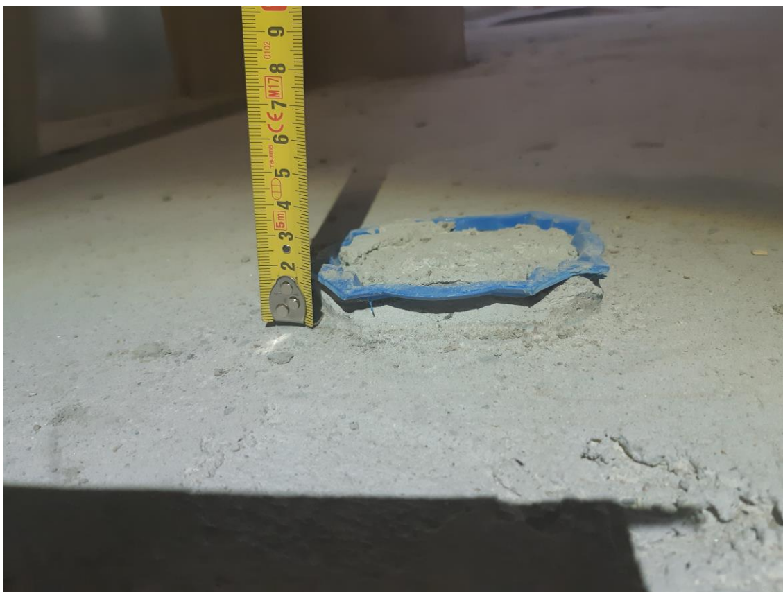
KUVA 4. Huonosti asennettu Vigilan Humi 2 –anturi
