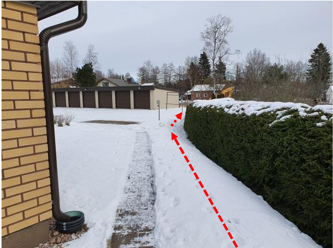
Kuva 32. Kaapelireitti autotallille (Kirjoittajan kuva).
