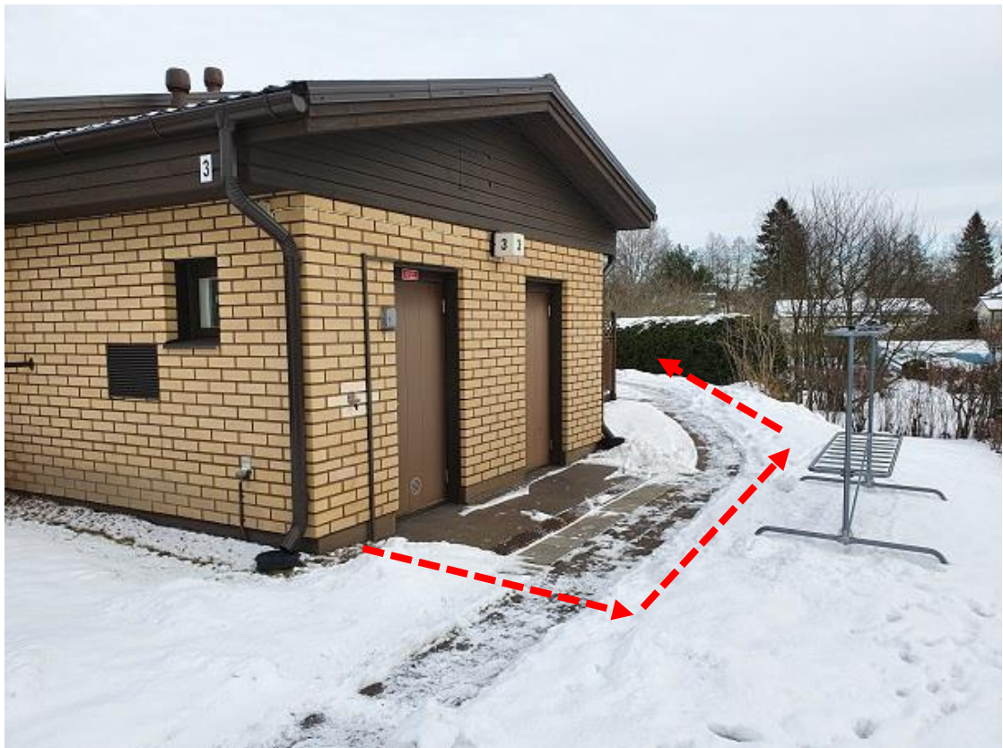
Kuva 31. Tekninen tila ulkopuolelta ja kaapelireitti (Kirjoittajan kuva).
