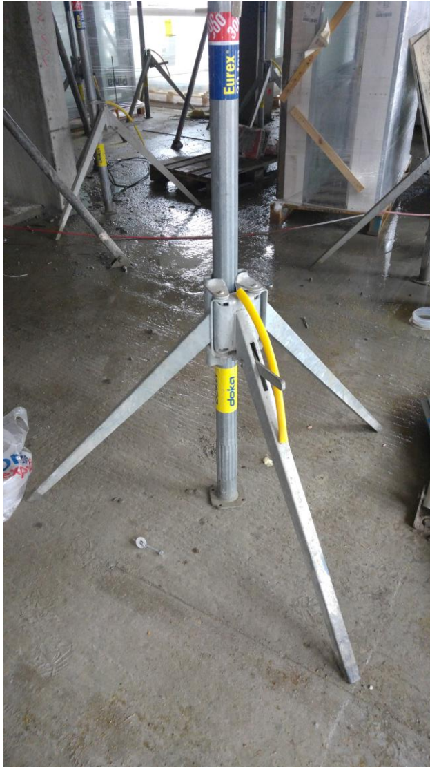
Kuva 7. Tukijaloin varustettu paikalleen asennettu holvituki.
