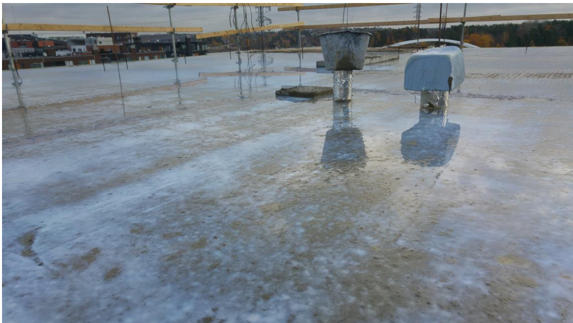
Kuva 13. Betonin päälle ruiskutettu jälkihoitoaine.
