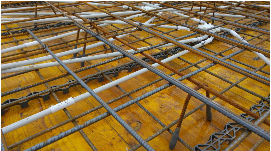
Kuva 11. Tukipukkien päälle asennettu yläpinnan raudoitus.
