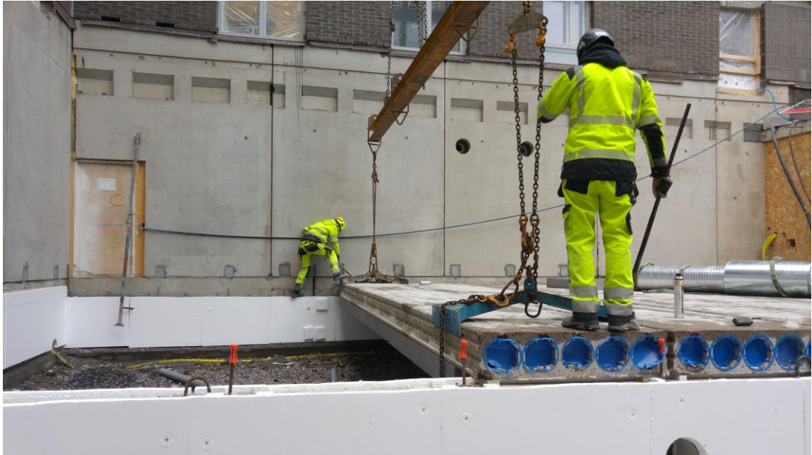
Kuva 3. Ontelolaatan paikalleenohjaus asennuskankien avulla.
