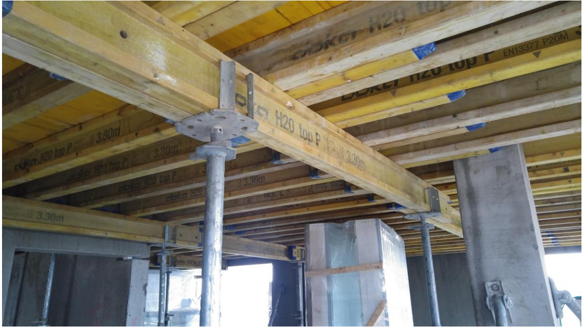
Kuva 8. Holvitukien kannattelema palkisto ja päälle ladotut muottilevyt.
