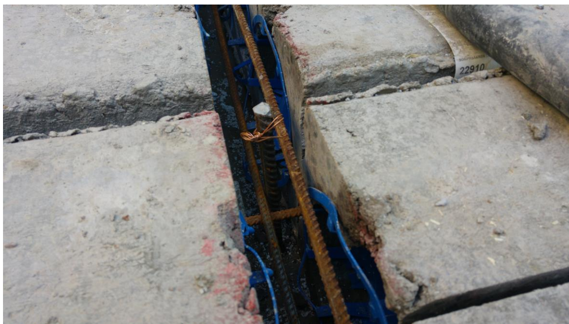
Kuva 4. Laatastoa kiertävä raudoitus.
