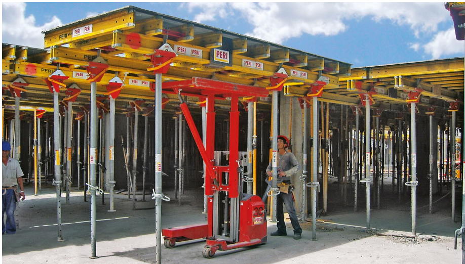
KUVA 1. Pöytämuottiyksikkö ja koneellinen siirtolaite. (Peri Suomi Ltd Oyj)
