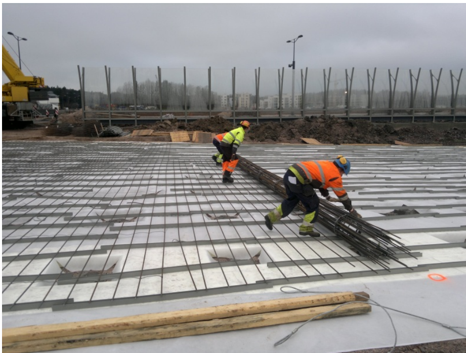
KUVA 11. Bamtec- mattorautoitteen asennusta. (kuva celsa-steelservice.fi)
