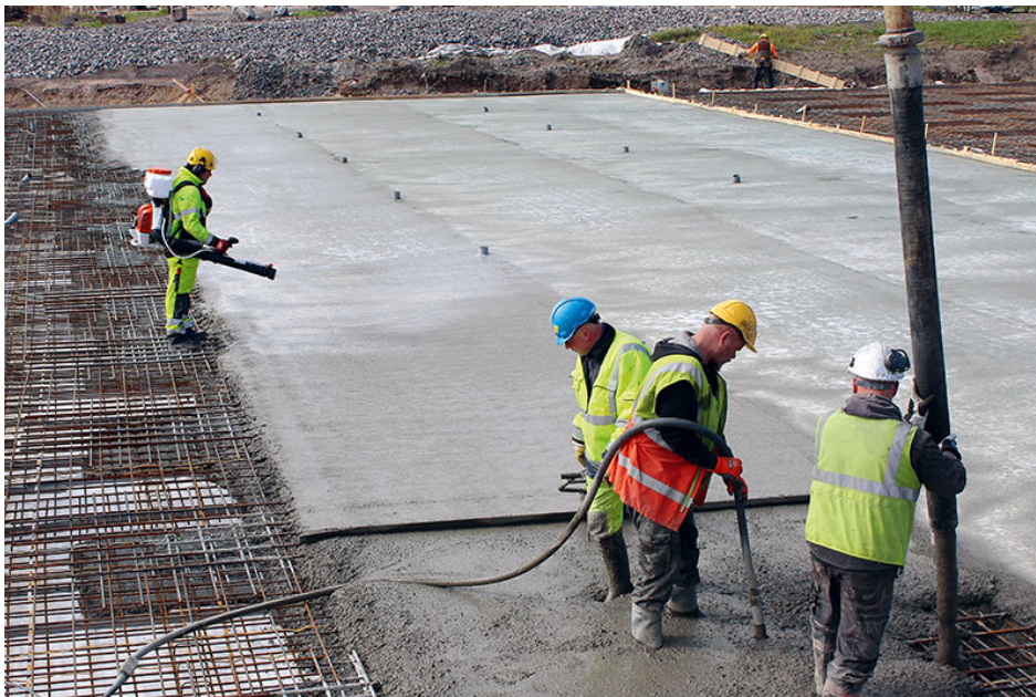
KUVA 13. Betonin jälkihoitoaineen levittäminen heti valamisen jälkeen. (kuva muottikolmio.fi)
