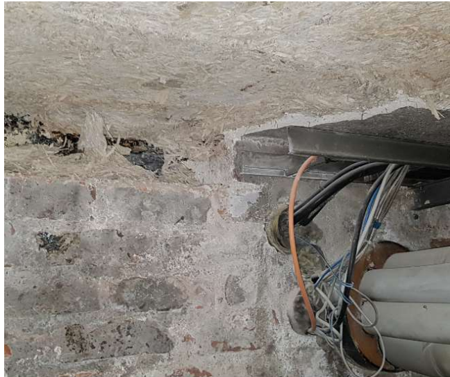
Kuva 23. Polttoainevaraston holvin sementtilastuvillaeriste, sekä sokkelin läpivientejä
