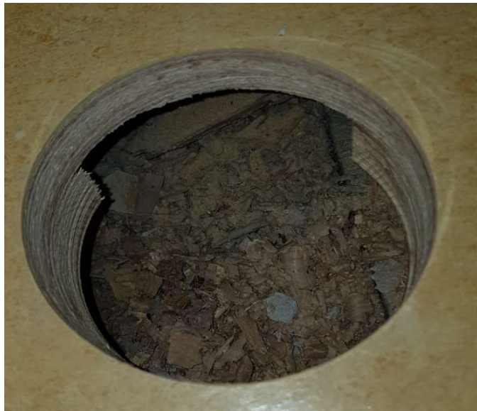
Kuva 43. Välipohjan rakenneavaus luokassa X.
