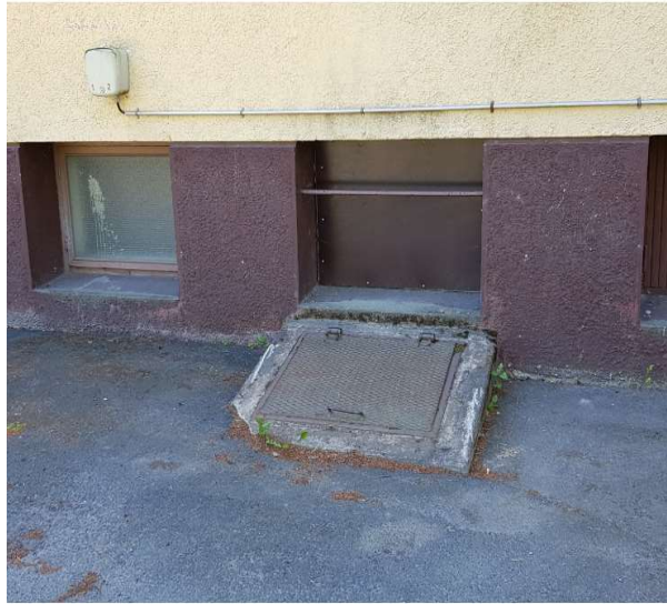
Kuva 19. Kellarin vanha huoltokuilu ulkopuolelta.
