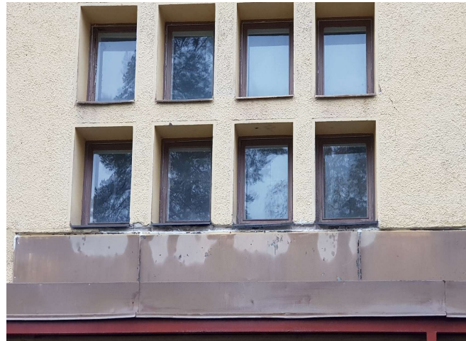
Kuva 34. Yleiskuva päädyn katoksen päältä.
