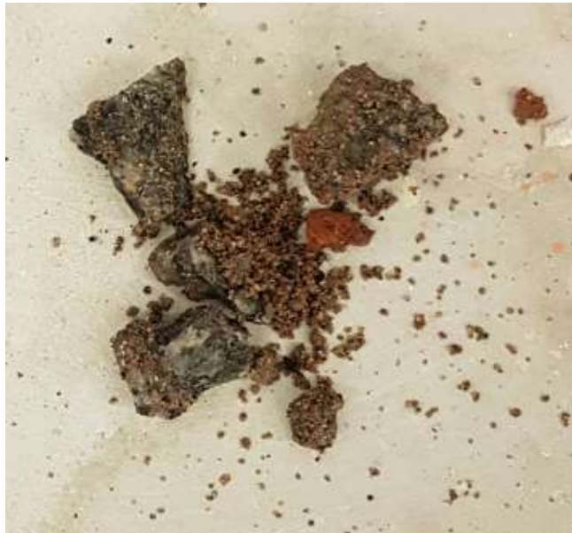
Kuva 6. Alustäyttö oli tarkastushetkellä vesimärkää.
