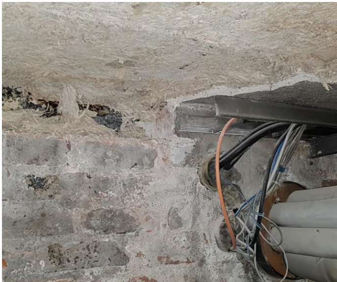
Kuva 26. Polttoainevaraston holvin sementtilastuvillaeriste, sekä sokkelin läpivientejä
