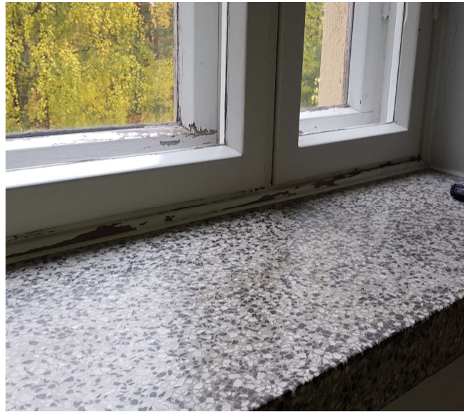
Kuva 33. Yleiskuva käytävän ikkunasta
