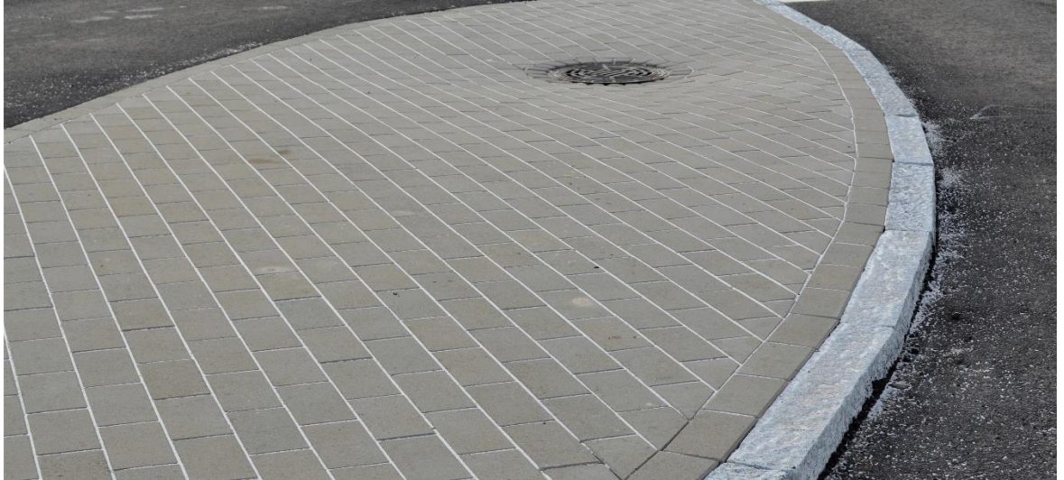
Kuva 11. Betonikivistä tehty kiveys.
