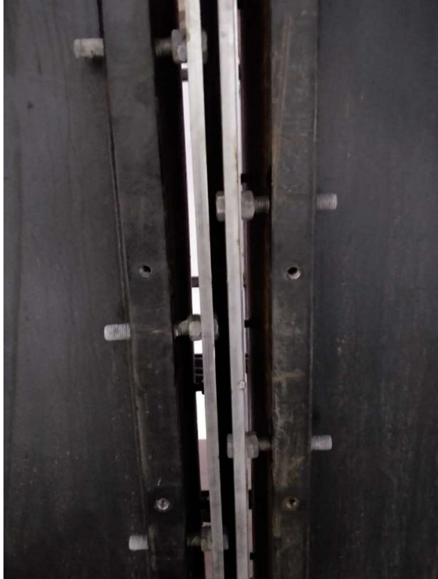
Kuva 7. Porttilehtirakenteen keskinivel asemituna
