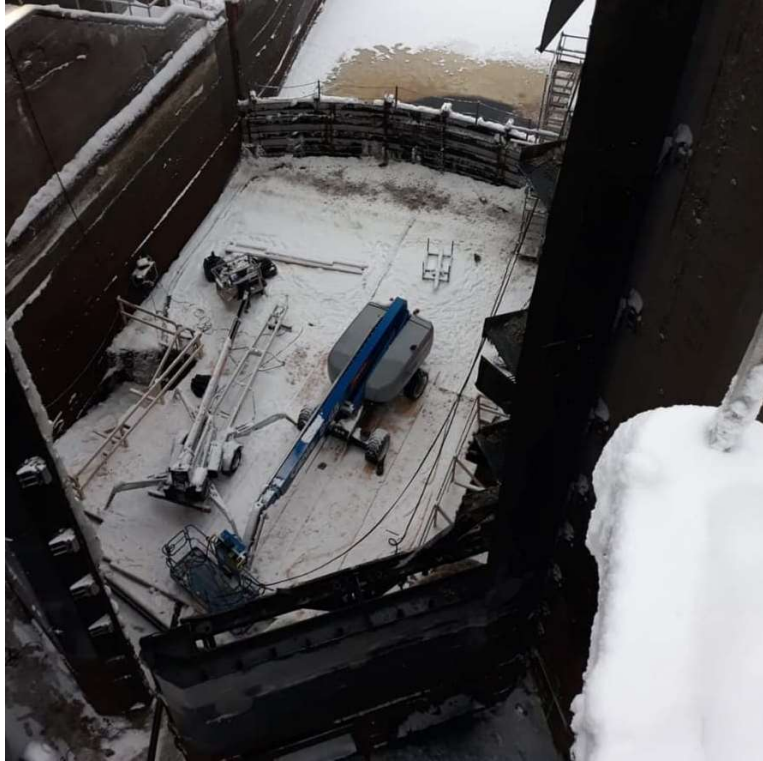
Kuva 4. Pällin sulun vanhojen porttilehtien purku
