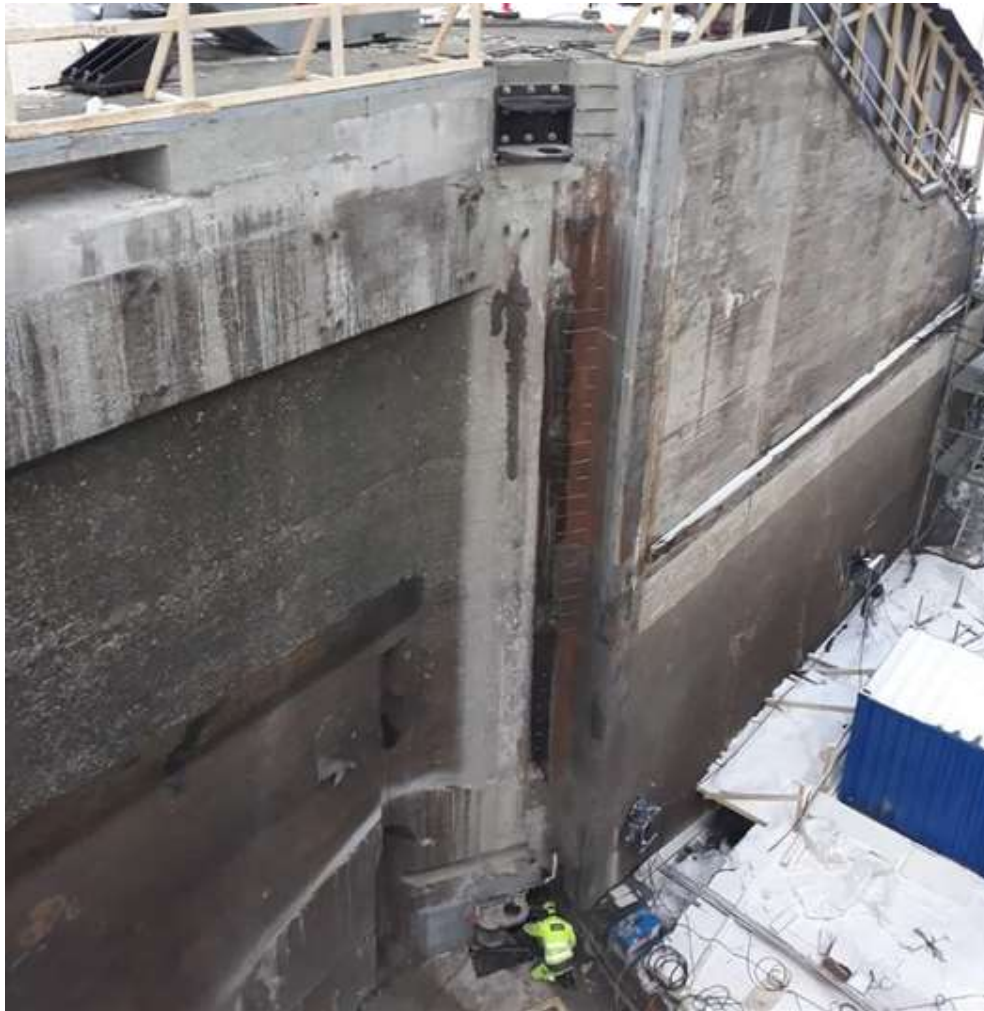
Kuva 6. Sulun pieli, jossa asennettu konsolit ja pielen vaakaraudoitus
