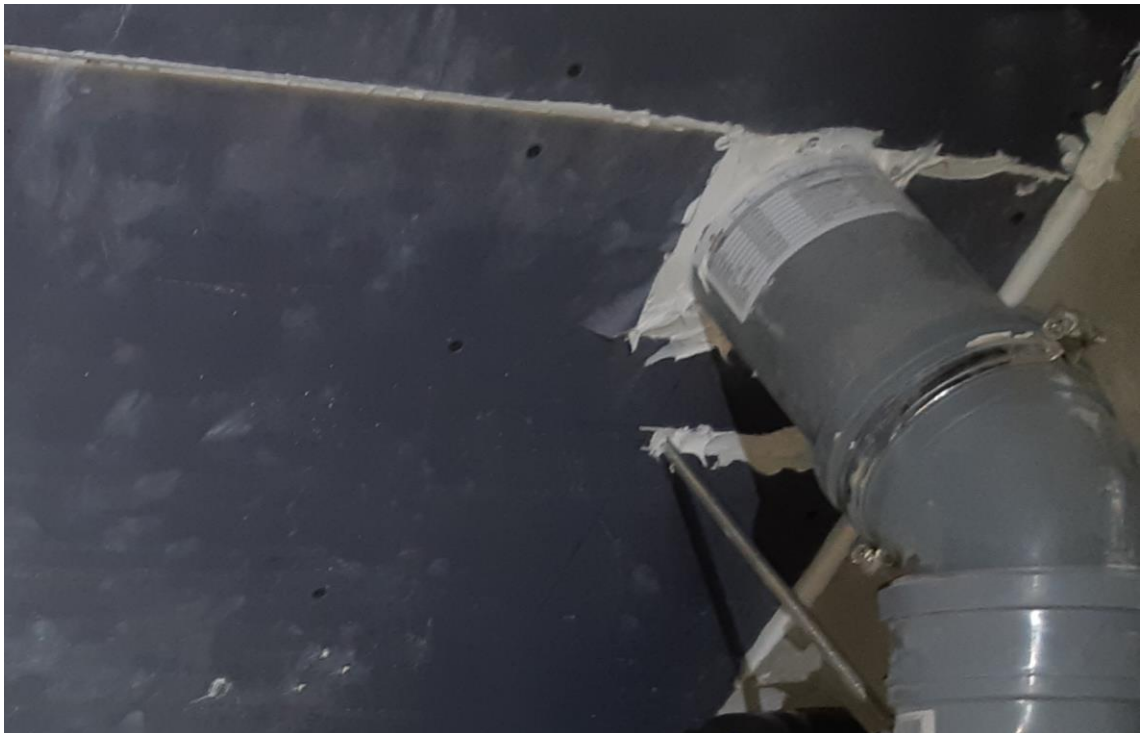
Kuva 15. Alakattorakenteen läpivienti kitattu elastisella saumamassalla.
