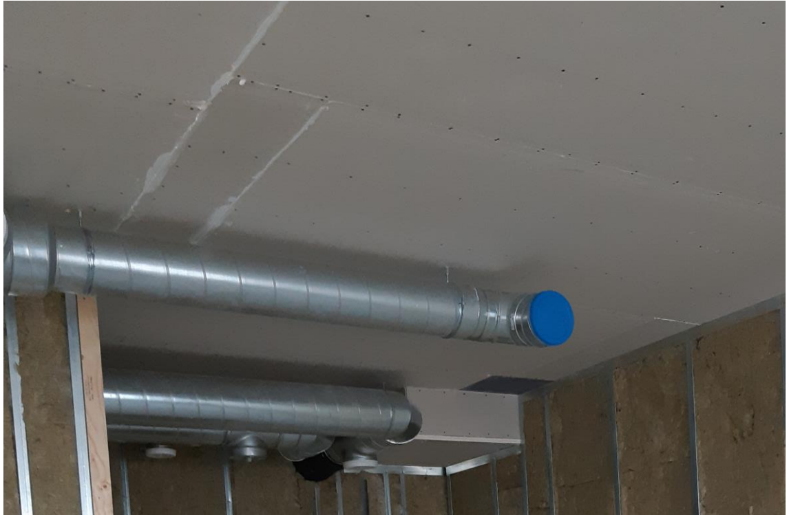
Kuva 14. Alakattorakenne levytetty kaksinkertaisesti kipsilevyllä ja osa levysaumoista kitattu elastisella saumamassalla.
