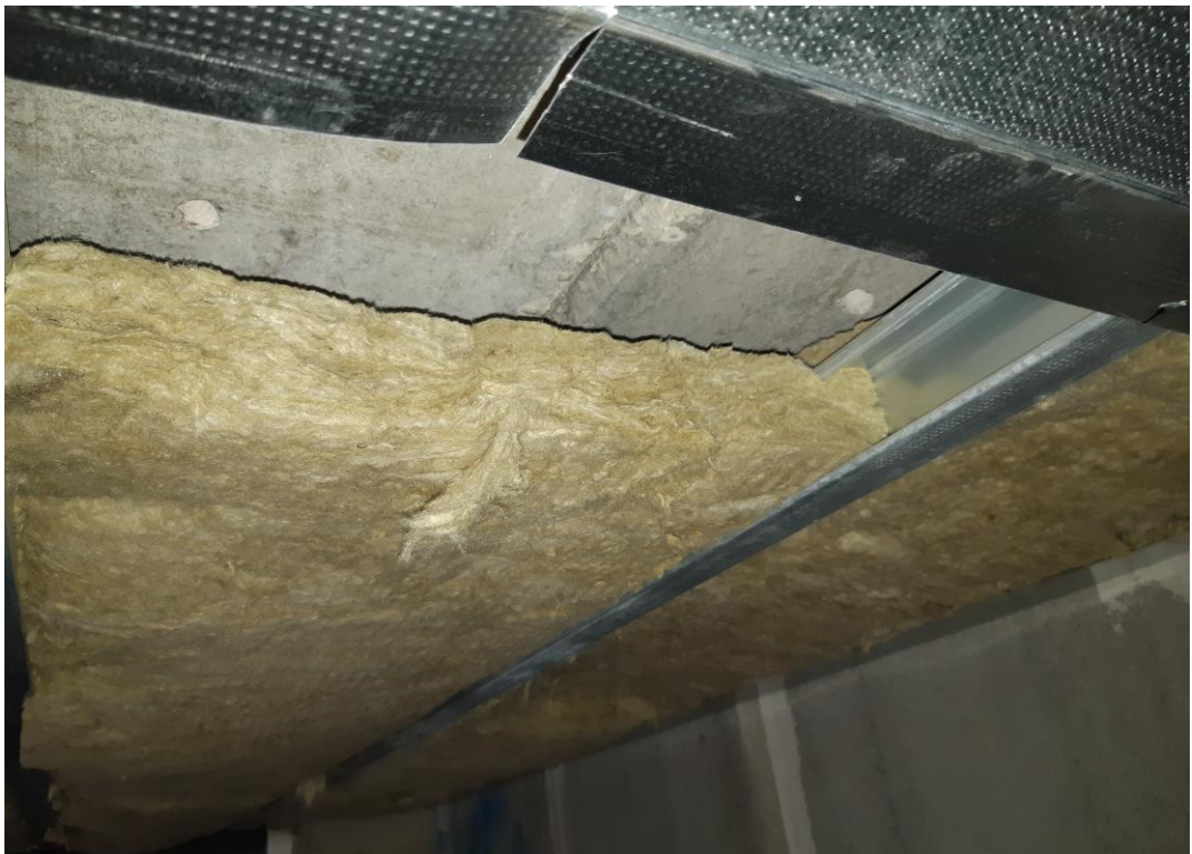
Kuva 13. Eristys asennettu rungon rankojen väliin.
