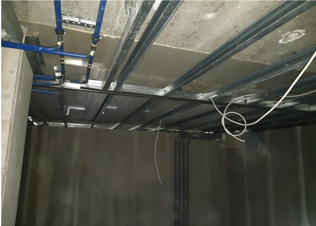
Kuva 12. Alakaton runko asennettu 50 mm irti välipohjarakenteesta.
