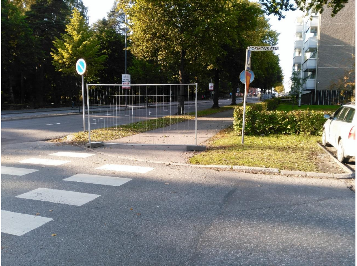
Kuva 3. Kevyenliikenteenväylä katkaistu ilman liikennejärjestelyjä. (Tomi Lapinlampi, Lappeenrannan kaupungin pyöräilyn kehitystyöryhmä 2017)
