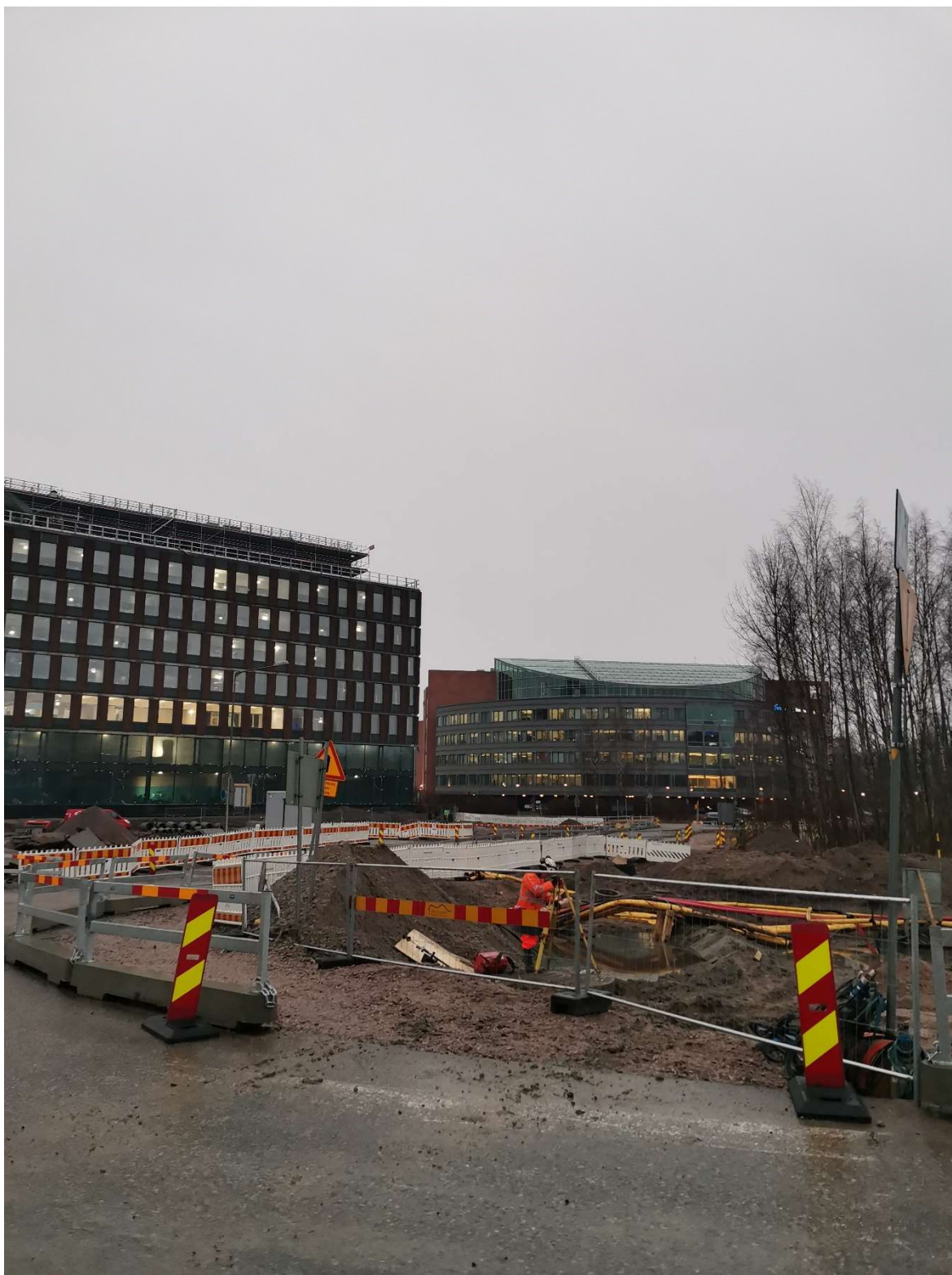
Kuva 18. Irtokivet ja hiekka asfaltilla voivat joutua pyörän alle ja aiheuttaa vaikeuksia liikumiseen, lisäksi saa työmaan näyttämään sotkuiselta
