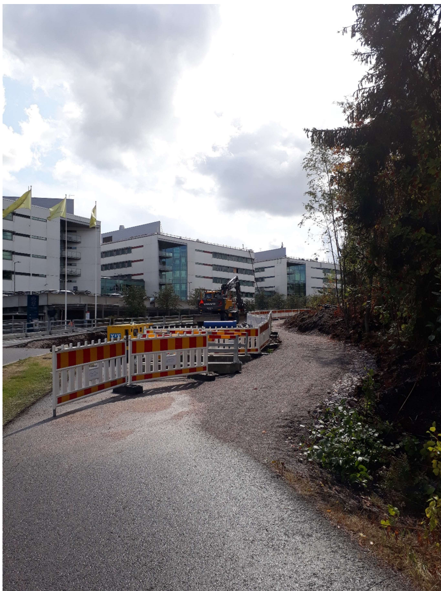
Kuva 20. Kävelyn ja pyöräilyn jaettu työnaikainen reitti on työmaa-alueen ja metsän välissä
