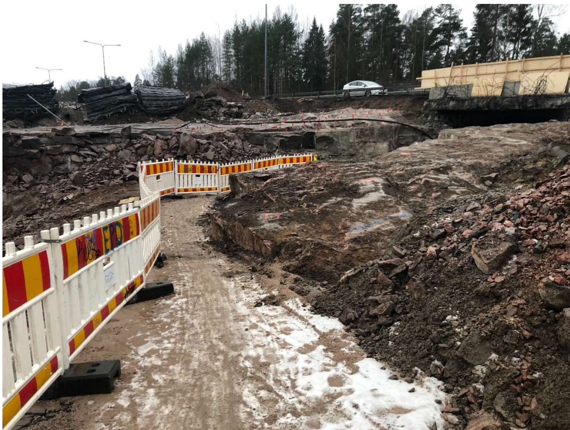
Kuva 21. Työnaikainen reitti on kaivannon ja kallion välissä (Salmensaari 2020)
