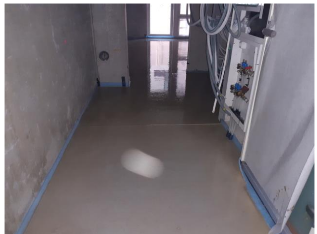
7. Varhaisjälkihoitoaineen levityksen jälkeen valu on valmis. Valu on kävelykuiva noin vuorokauden kuluttua valusta.
