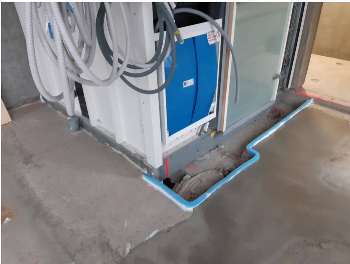
KUVA 7. Kylpyhuone-elementin ympäryys
