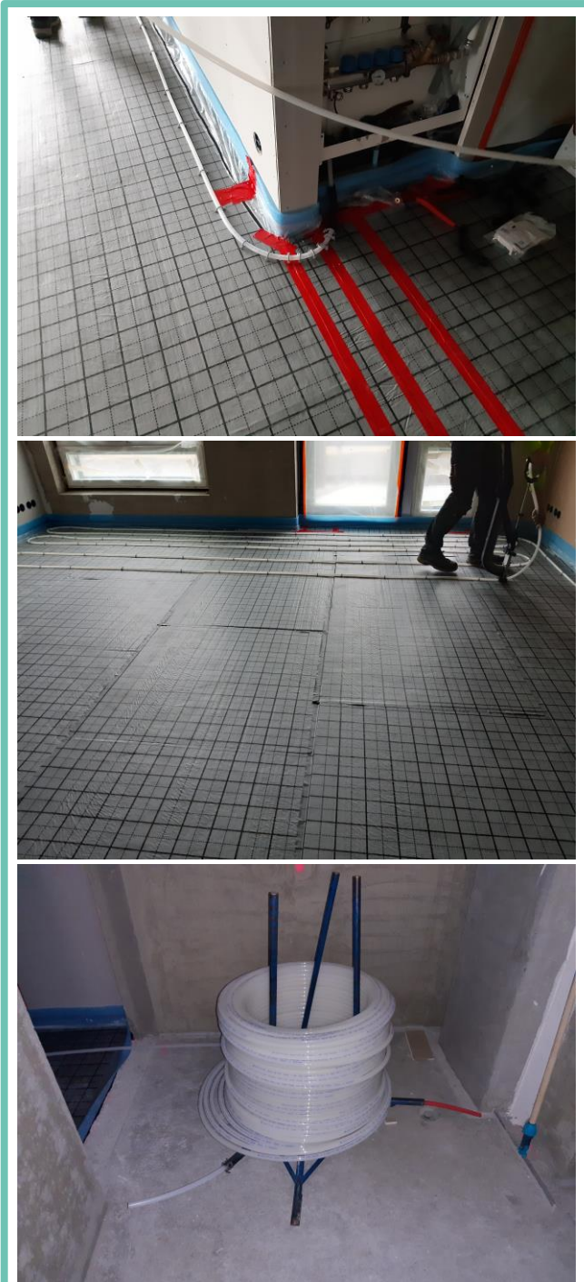
4. Putkituspiirien asennus aloitetaan kiinnittämällä putken pää jakotukkiin ja asentamalla jakotukin alapuolella LK Putkentaivutustuki. Putkea kiinnitetään LK Sankakiinnittimellä suunnitelmapiirustusten mukaisesti sitä mukaa, kun sitä vedetään kelalta.
