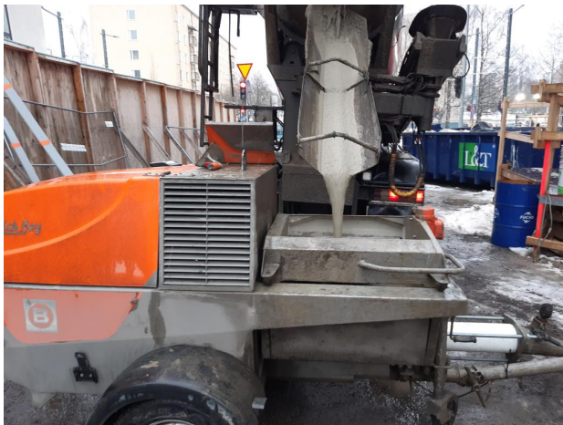
4. Betonitasoite toimitetaan työmaalle tavallisella kuljetussäiliöautolla ja pumpataan kerrokseen erillisellä ruuvipumpulla.
