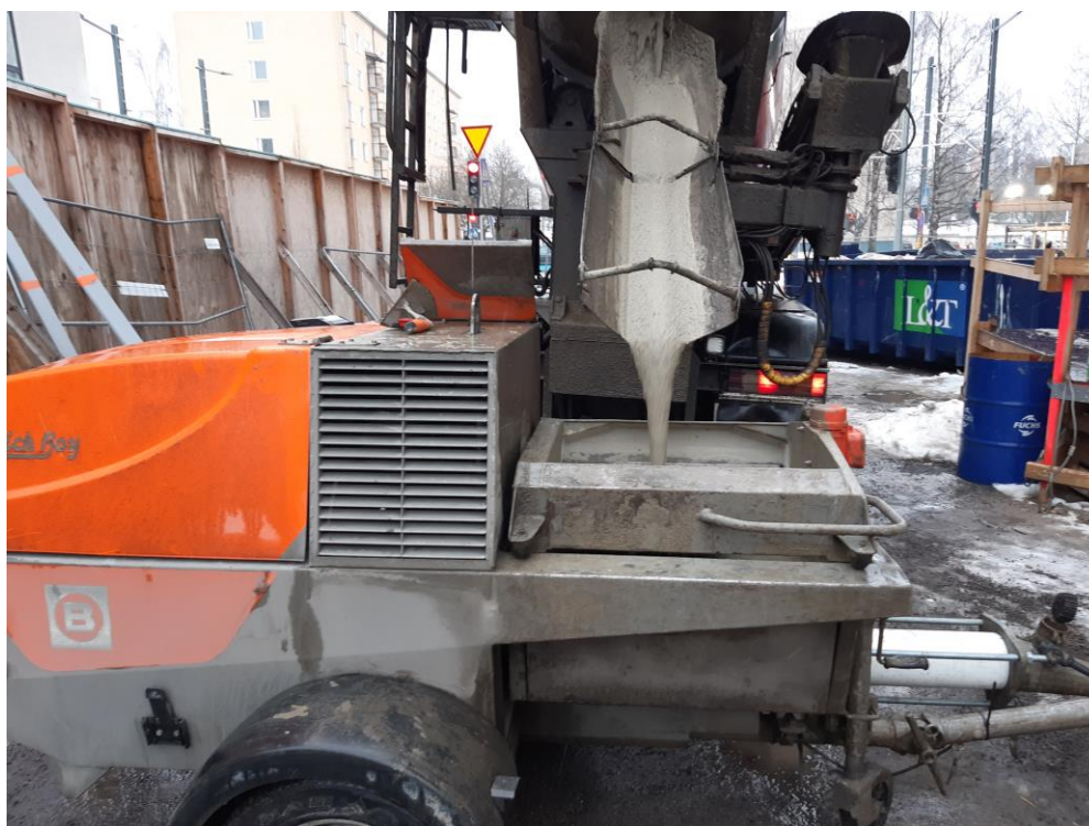
KUVA 2. Betonikuljetusauto ja ruuvipumppu
