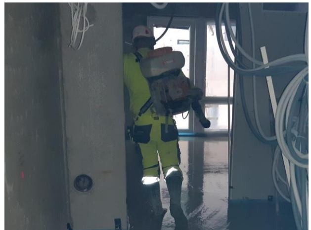
6. Kun massaa on oikea määrä, se hevos-tetaan, jotta vesi ei erotu pintaan, ja massa leviää kunnolla. Hevostuksen yhteydessä valun päälle suihkutetaan varhaisjälkihoitoaine.
