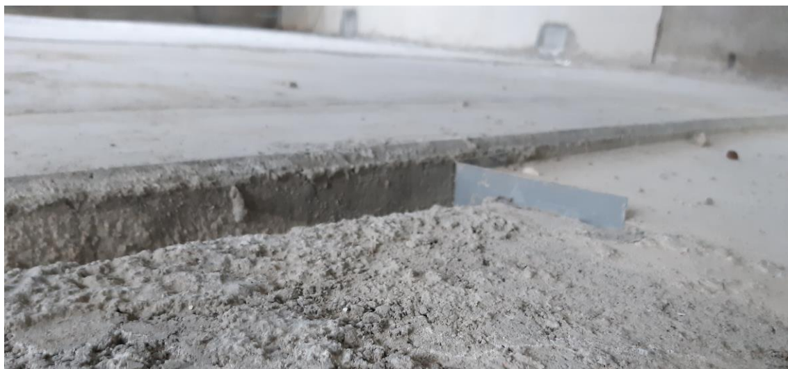
KUVA 3. Vierekkäisten ontelolaattojen korkoero
