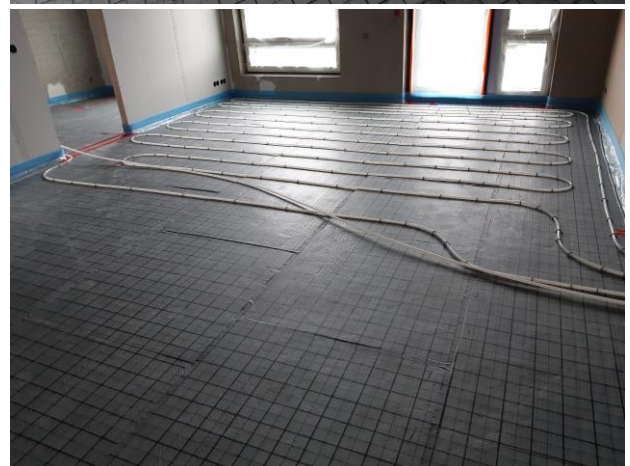
5. Valmis piiri katkaistaan, asennetaan LK Putkentaivutustuki ja liitetään jakotukkiin. Seuraavat piirit tehdään vastaavasti.
