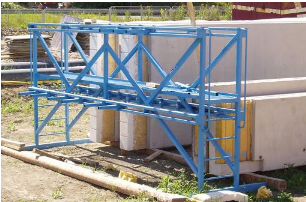
Kuva 23. Elementtifakissa välivarastoidaan elementtejä ja muottikalustoa. 111
