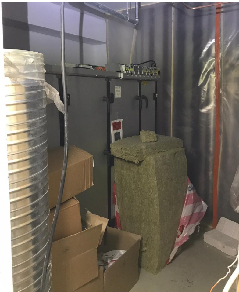
Kuva 21. Redin tornitaloissa IV-konehuoneet ovat hyvin pieniä ja kompakteja, mutta niitä on joka toisessa kerroksessa, kasvattaen ilmanvaihtokoneiston määrän todella suureksi. 86
