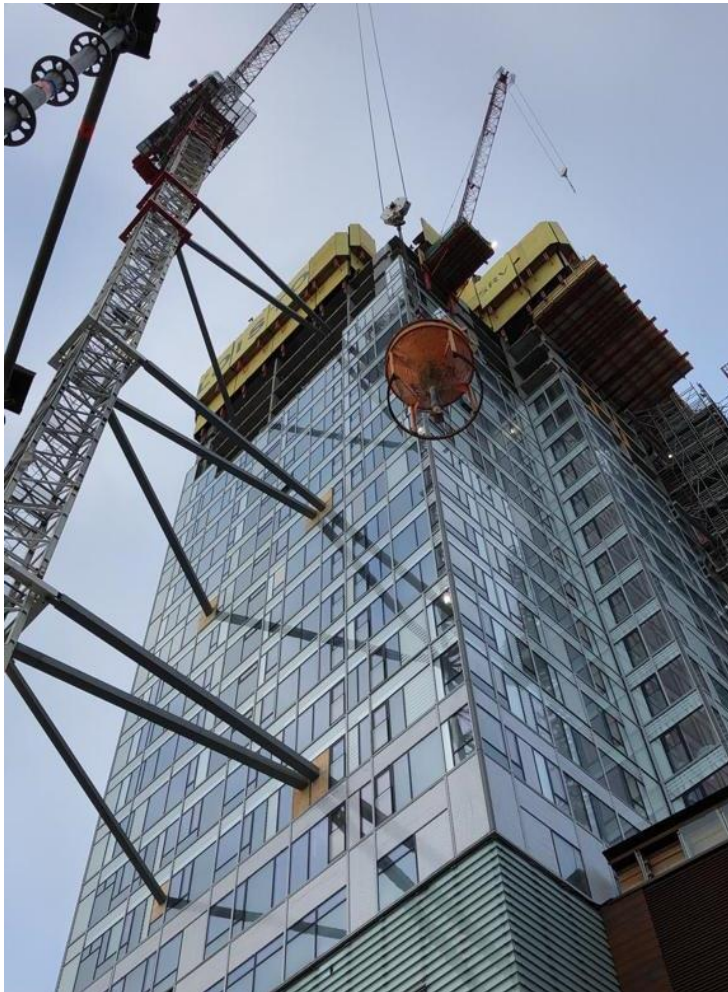
Kuva 9. Redin Loiston ulkonosturin harukset täytyy olla asennettuna viiden kerroksen välein. Harukset kiinnitetään teräspilareihin, jotka on liitetty runkoon holvivalujen yhteydessä. 58
