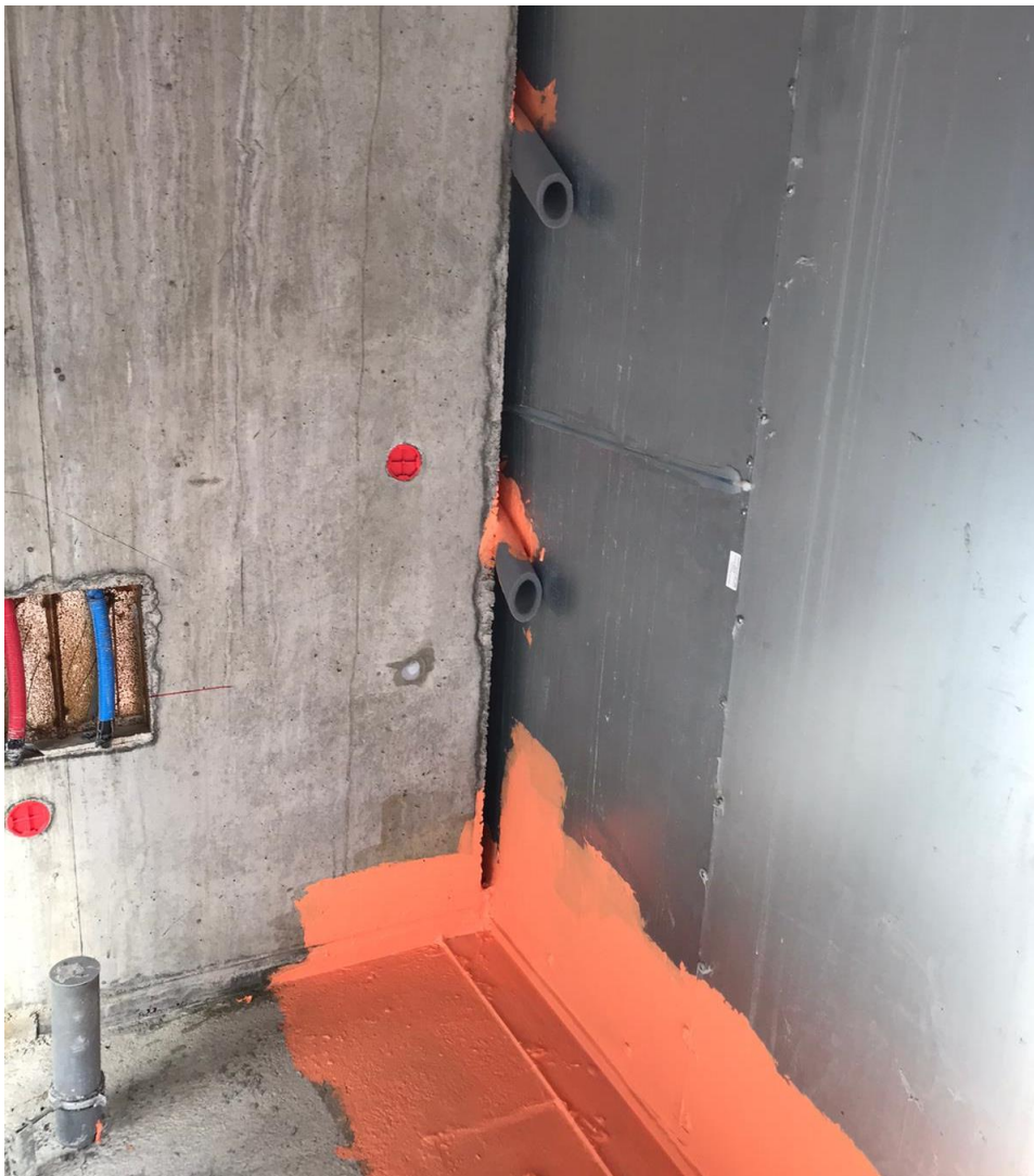
Kuva 16. Julkisivuasennuksen jälkeen tehtävä vesikatko. Vaakasaumat eristetään, sekä alemman kerroksen julkisivu verhoillaan pressuilla. Julkisivun ja betoniseinien väleihin asennetaan kouruja, joita pitkin väliin valuva vesi ohjataan oikealle puolelle. 70
