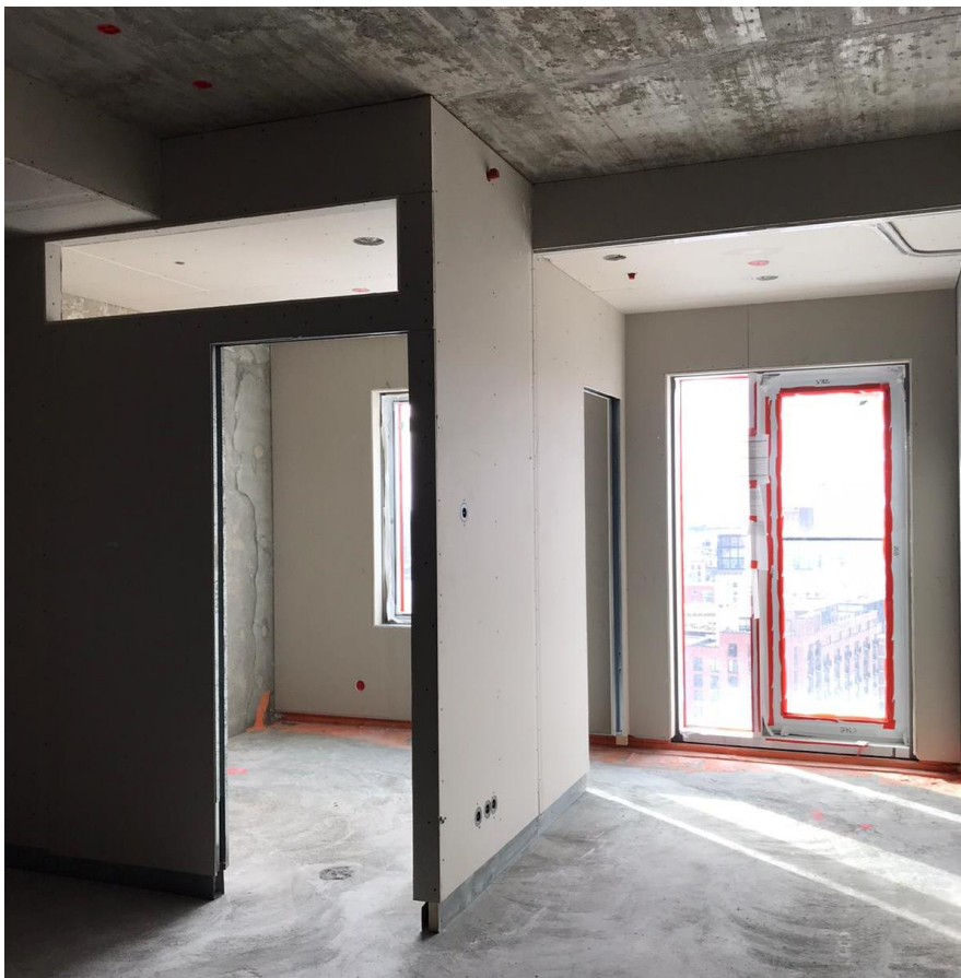
Kuva 18. Redin tornitalojen levyväliseissä on tavallista haastavampia ratkaisuja, kuten vasemmalla näkyvä sisäikkuna, sekä oikealla alakatossa näkyvä viherhuoneen lasiseinien kisko. 77
