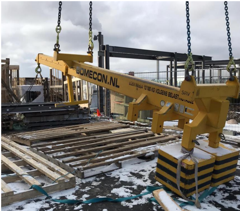
Kuva 14. Vastapainopuomi nostovalmiudessa elementtiasennusta varten. 68
