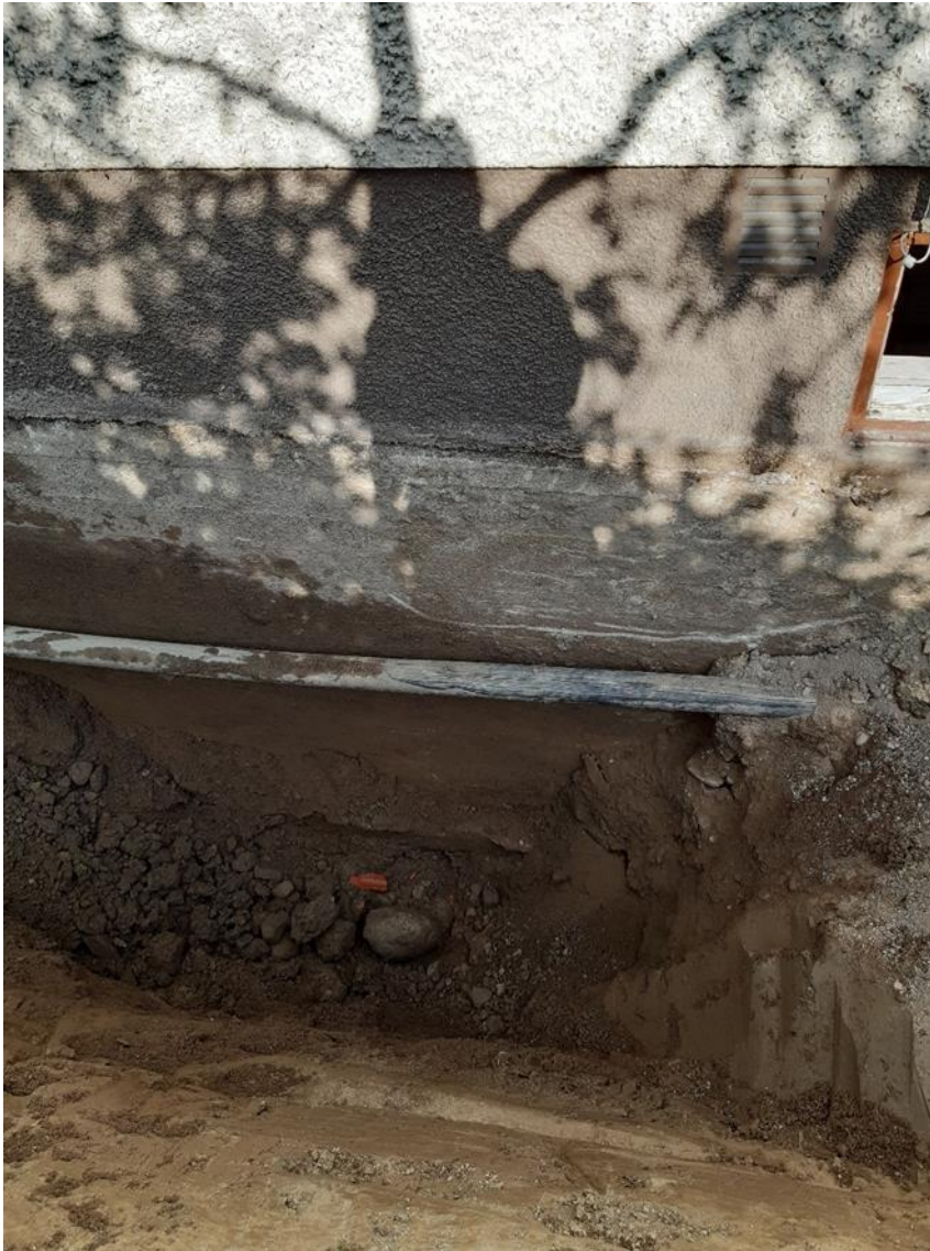
Kuva 12. Esimerkkikohteen länsipuolen seinustalta, kuvasta voi ha-vaita savitiilisen salaojaputken sekä sadevesiputken.
