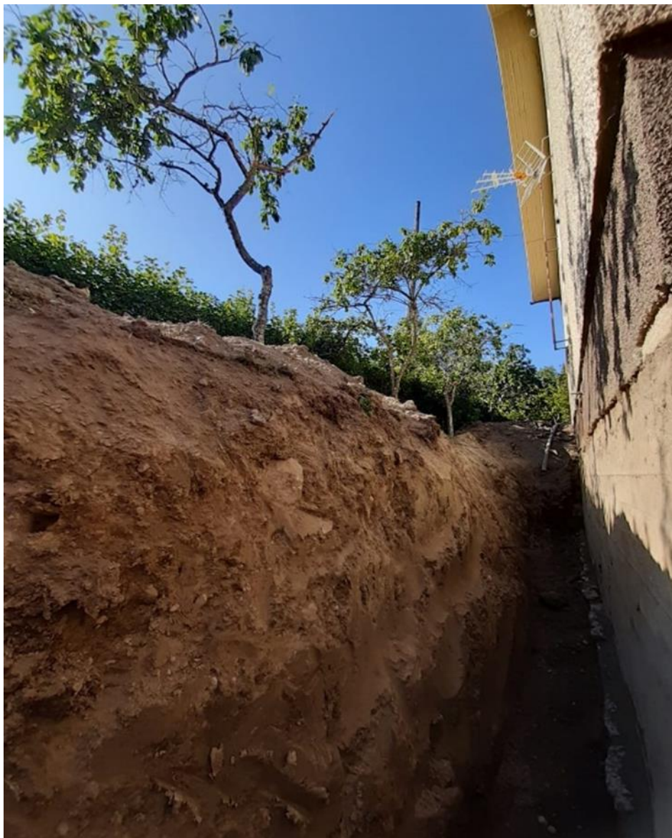
Kuva 11. Esimerkkikohteen länsipuolen seinustan sokkeli kaivettu anturaan asti auki.
