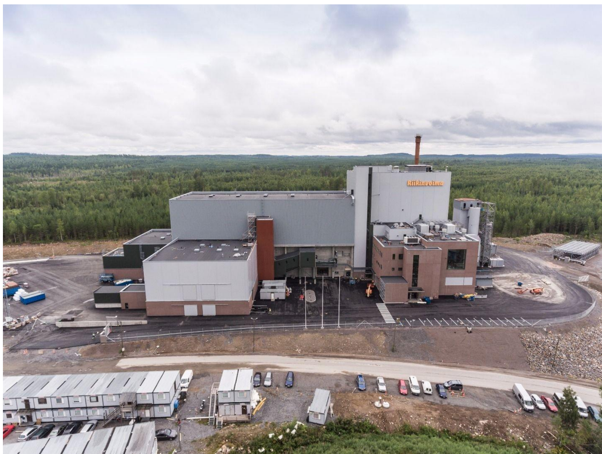
Kuva 1. Riikinvoiman ekovoimalaitos (varkaudenalueämpö.fi)
