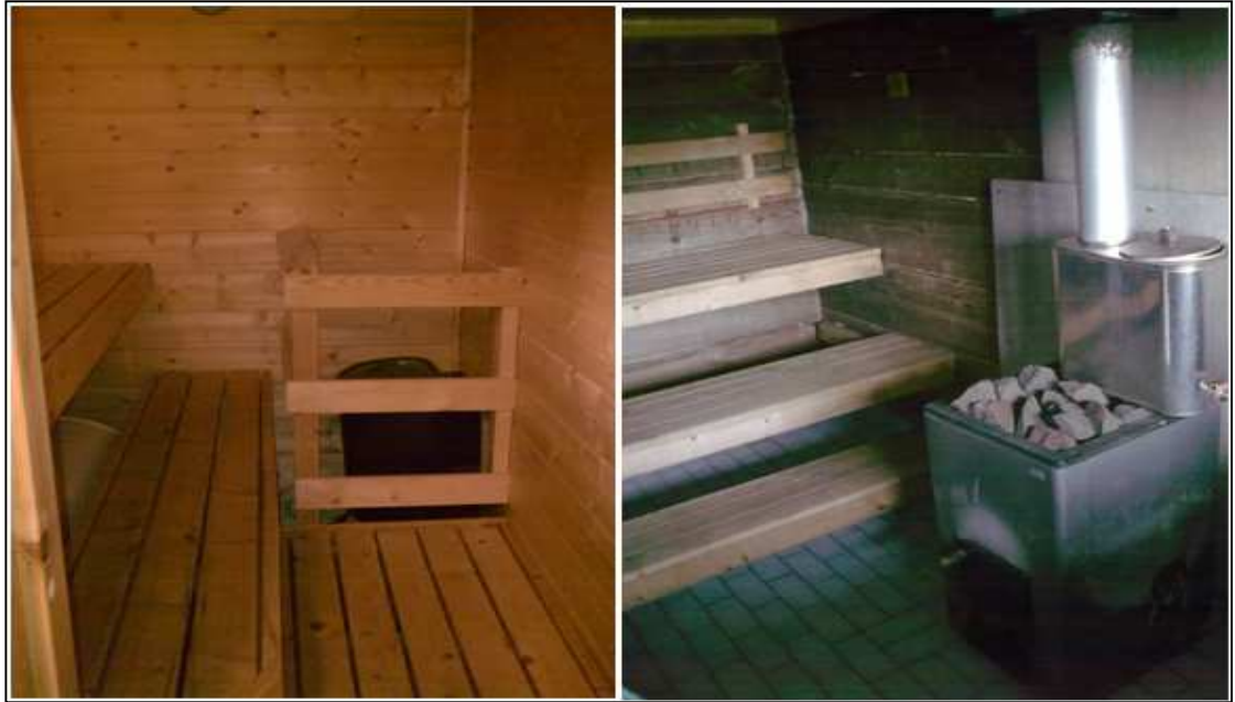
KUVA 6. Vasemmalla asianmukaisella turvakaiteella varustettu ja oikealla turvakaiteeton saunatila (Suomalainen 2011)
