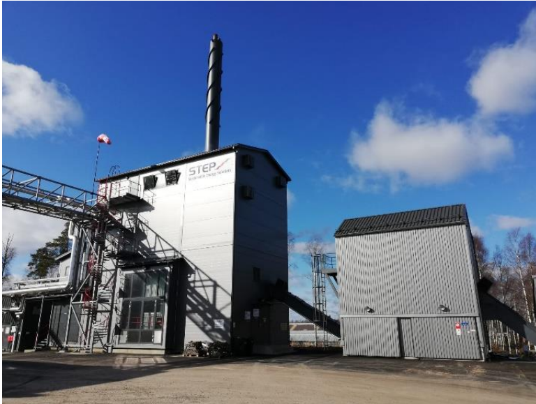
KUVA 1. Kaustisen höyrykattilalaitoksen biokattilarakennus vasemmalla ja polttoaineen seulontarakennus oikealla
