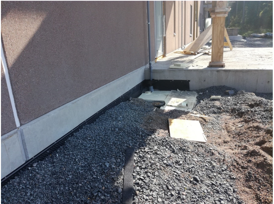
Kuva 19. Täyttö patolevyä vasten.
