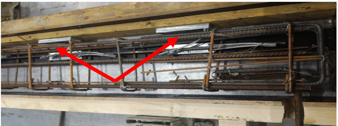
Kuva 4. Sokkelielementin muotti raudoitettuna.
