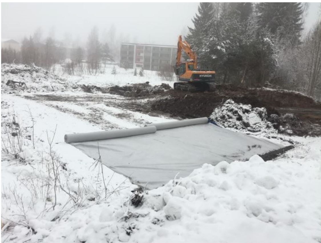
Kuva 15. Kaivutyöt ja suodatinkangas vahvuudeltaan N3.
