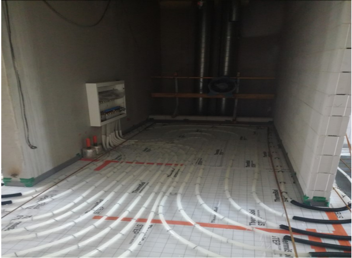
Kuva 12. Lattialämmitysputkisto kiinnitettynä askeläänistyroxiiin.
