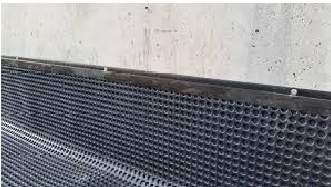
Kuva 18. Patolevy asennettuna ylälistan kanssa.
