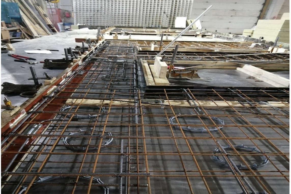
Kuva 11. Julkisivuelementti ikkuna- ja oviaukko varauksineen raudoitettuna.
