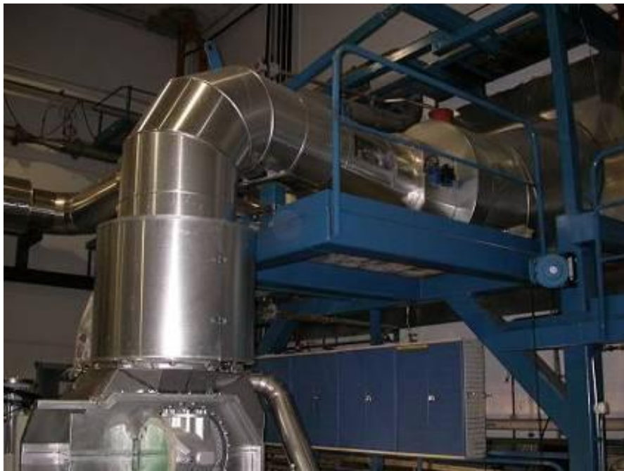
Kuva 16. Työtaso johon pakoputki on tuettu.
