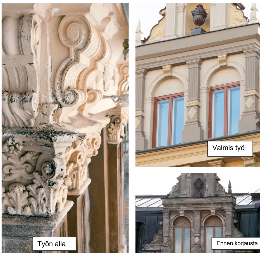
Kuva 7. Julkisivun peruskorjaus sisältäen ulkoseinän koristeiden korjaus- ja uusimistöitä. [6.]
