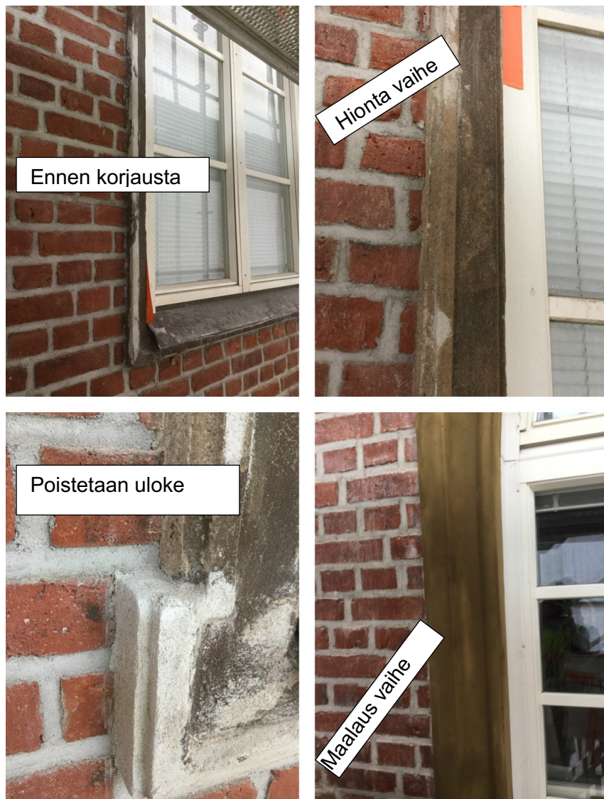
Kuva 9. Ikkunanpielien peruskorjaus vaiheittain.
