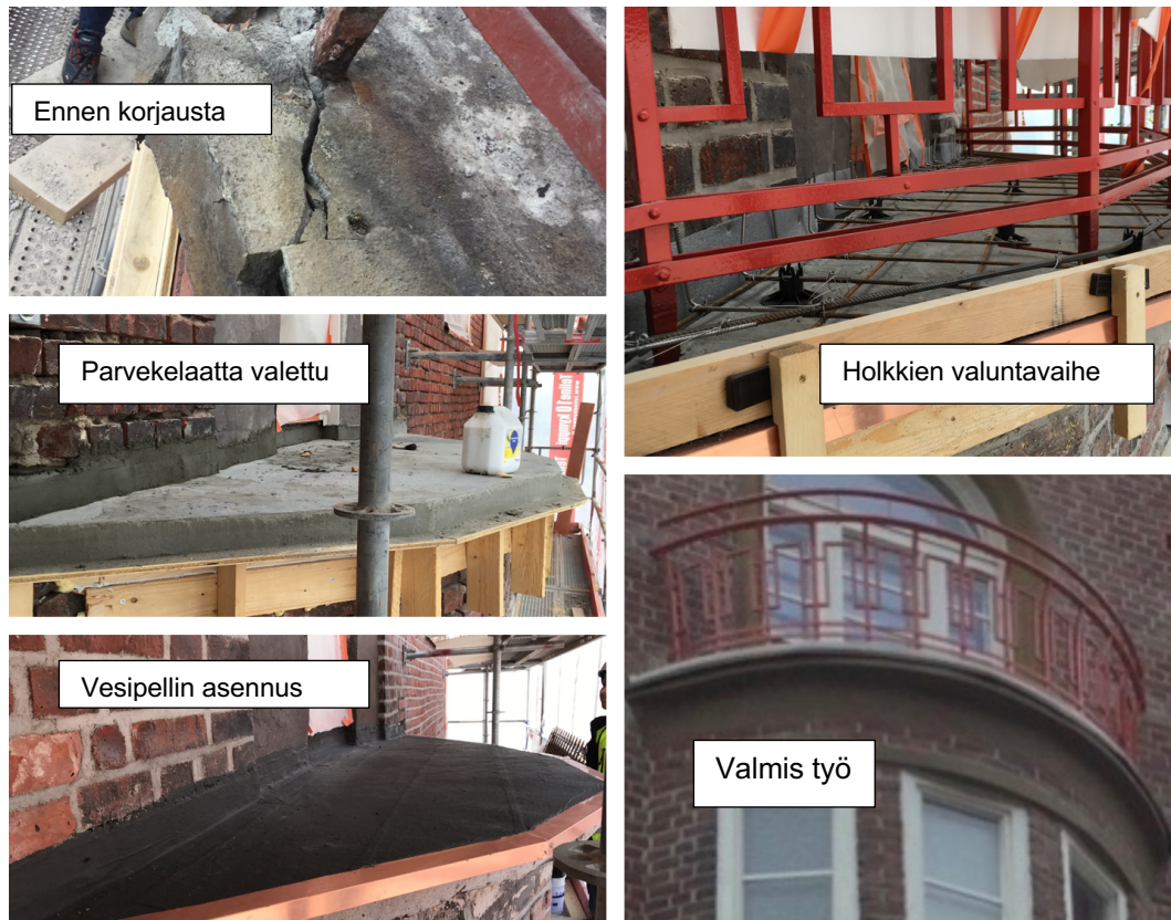
Kuva 11. Parvekkeen korjausrakentamisen vaiheita.
