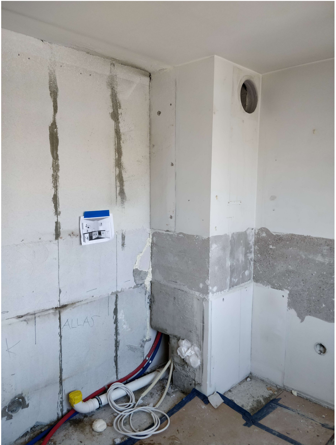
Kuva 2. Kuvassa keittiön hornin LVI-asennuksia.
