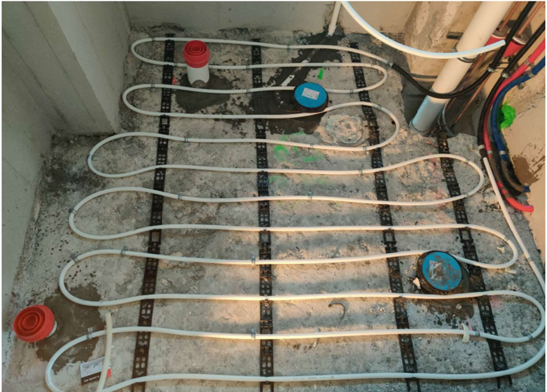
Kuva 8. Kuvan oikeassa yläreunassa näkyy märkätilan lattian kantavaan laattaan tehty roilo.
