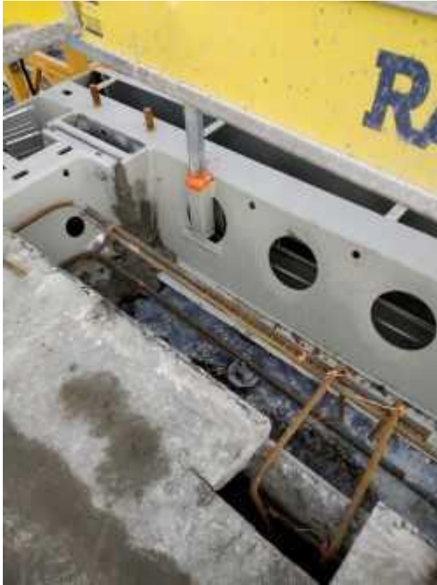
Kuva 9. Reunakaukalo jää kaiteistuksen ulkopuolelle (Triplan työmaa)
