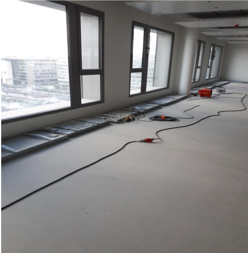
Kuva 5. Lämpölevykuivaus käynnissä (Triplan työmaa)
