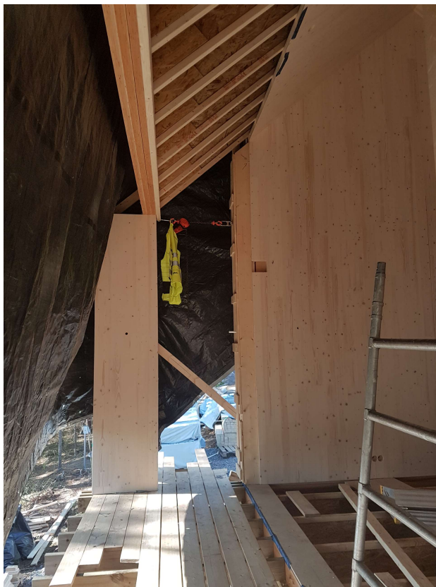
Figur 10. Tillfällig förankring under montage.
