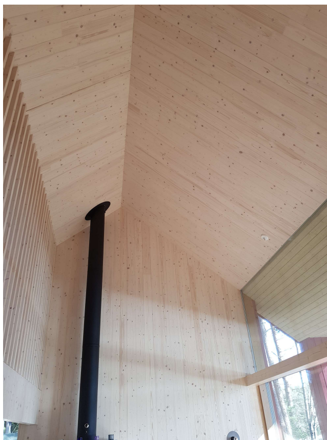
Figur 3. CLT:s färdiga och listfria innerytor efter monteringen.
