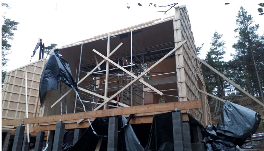
Figur 9. Strävning av CLT-element.
