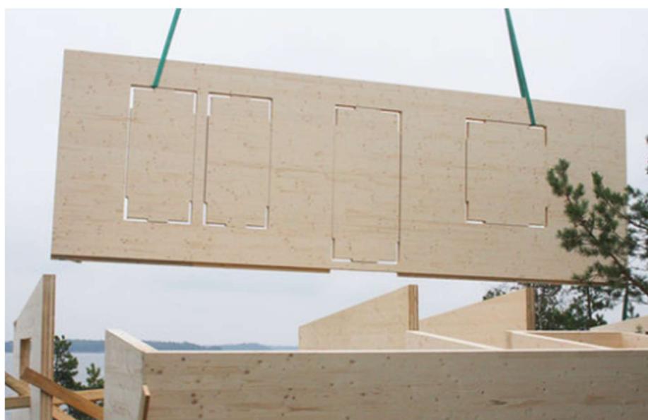
Figur 8. Stora öppningar sågas bara upp delvis vid transport och lyftning. (Timberpoint, 2020)
