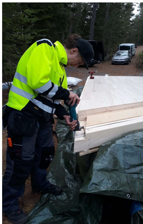
Figur 4. Tilläggsarbete på grund av måttavvikelse.
