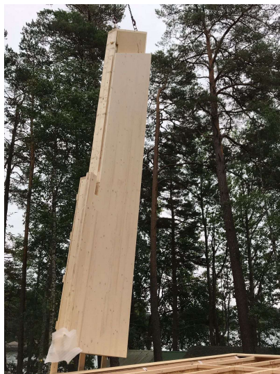
Figur 7. Lyftning av CLT-element med hjälp av lyftögla.
