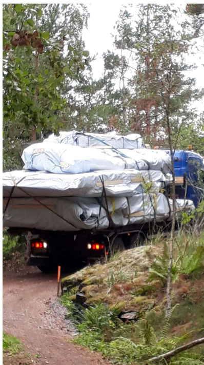
Figur 5. Liggande transport av CLT element.
