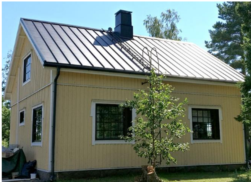
Kuva 13. Jyrkkä katto (Kymppi-Katto Oy 2020).
