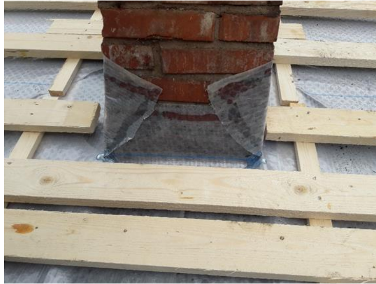
Kuva 16. Aluskate (AKV) savupiipun kohdalla.
