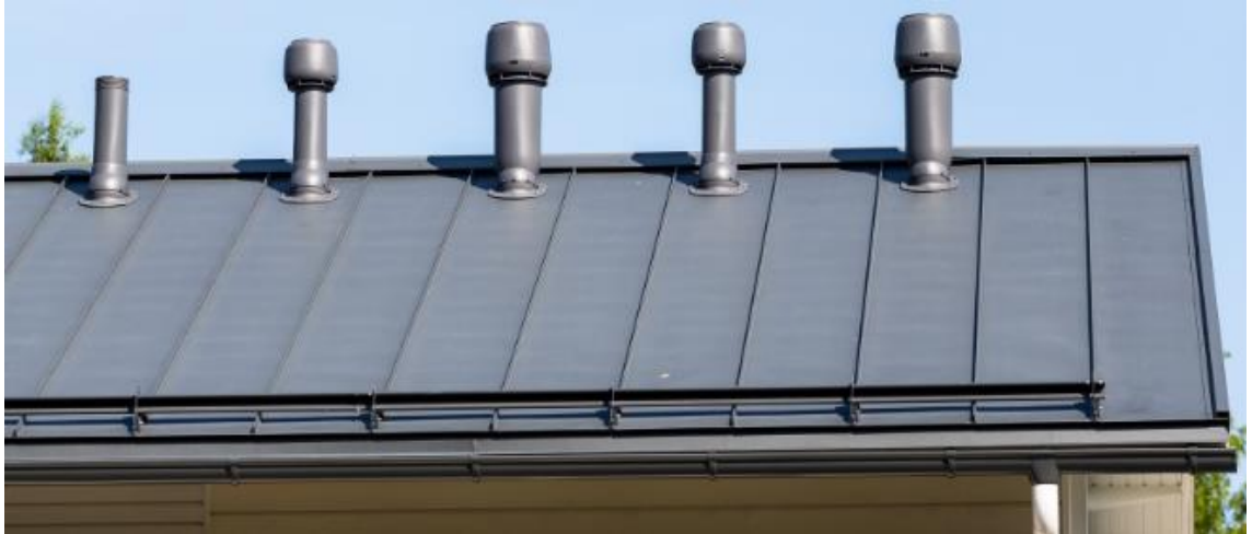
Kuva 18. Läpivientejä jyrkällä katolla (Rakentaja 2020).
