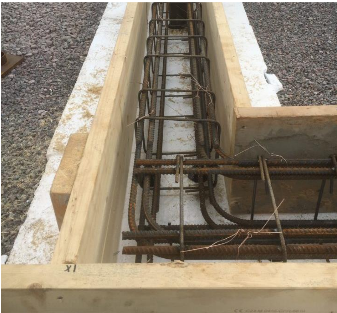
KUVA 6. Valumuotti ja raudoitus (Rakennusliike Koivu Oy 2020).
