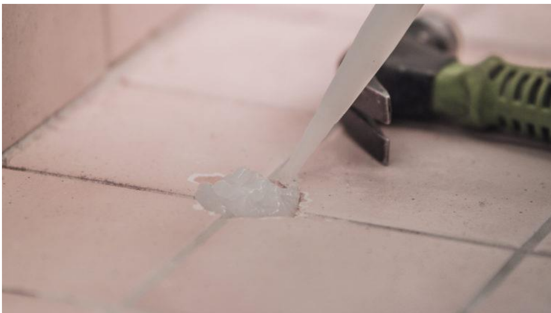
KUVA 20. Näytteenottoreiän peittäminen (Asbesti.fi 2020).
