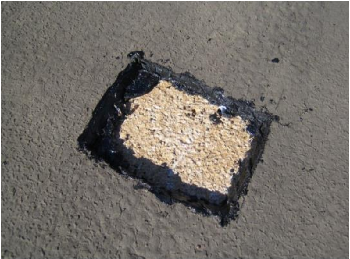
KUVA 22. Näytettä varten avattu bitumikate (RT – Haitta-ainetutkimus 2016).
