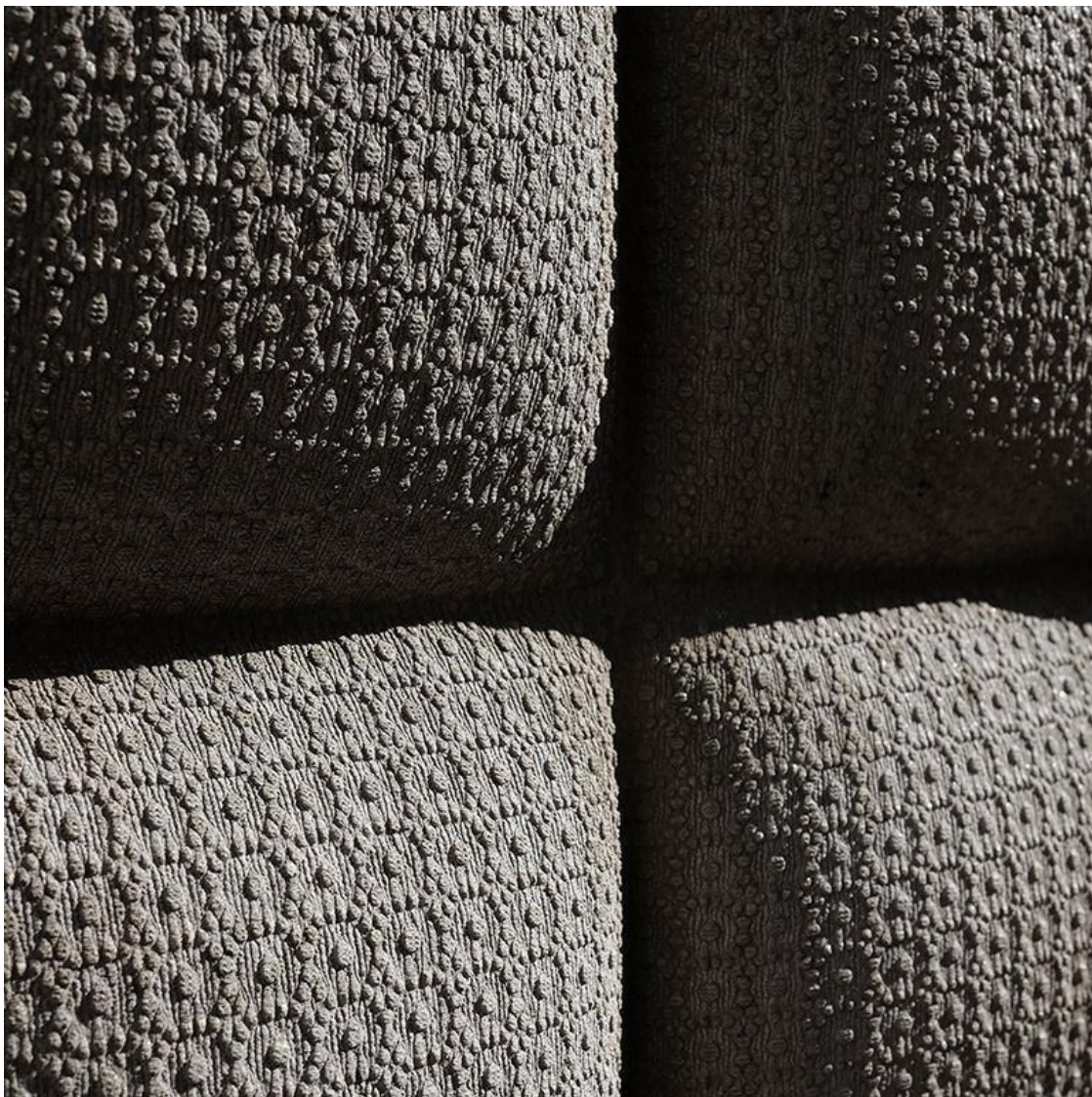
KUVA 4. Betoni omaksuu muottikaluston jäljen lähes täydellisesti (Consolis 2020).
