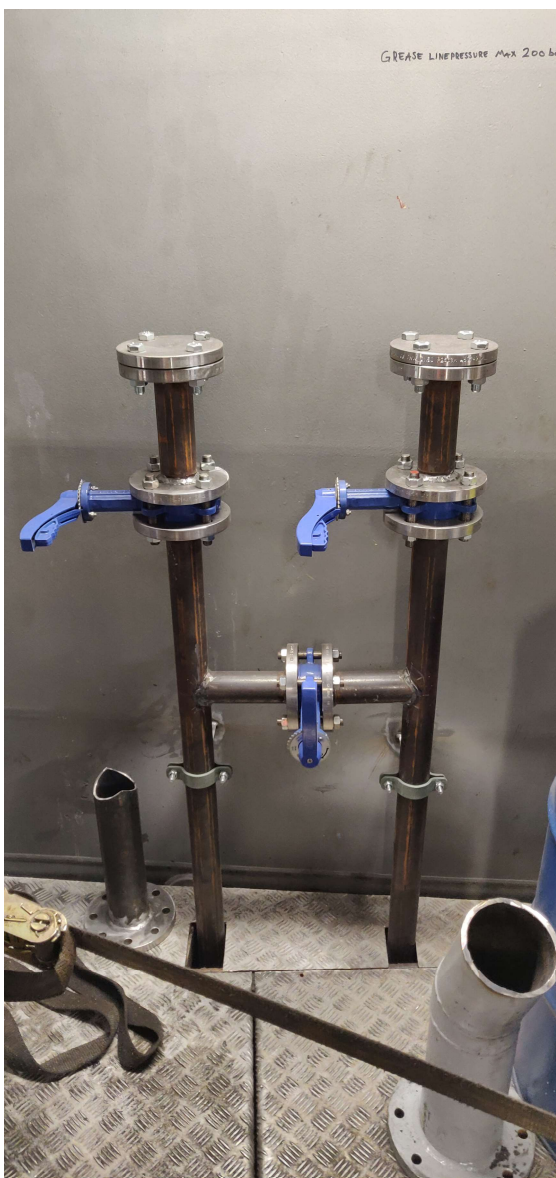
Figur 18 – Rörledningar som kommer upp från huvud kylsystemet för att ta tillvara extra värme för värmebatteriet. (Figur 19)
