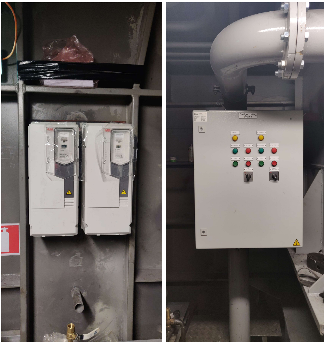
Figur 14 – Till vänster ABB styrenheter, till höger kontrollpanelen för kylsystemet. (Figur 15)
