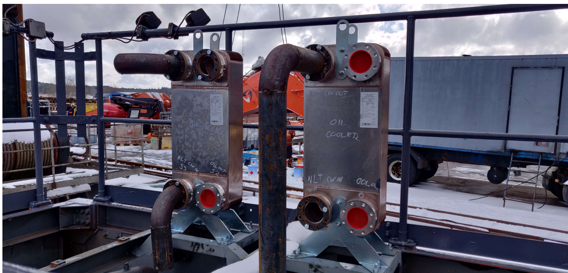
Figur 15 – Plattvärmväxlarna till hydraulikkylningen, tillverkare Alfa Laval. (Alfa Laval, 2020)
