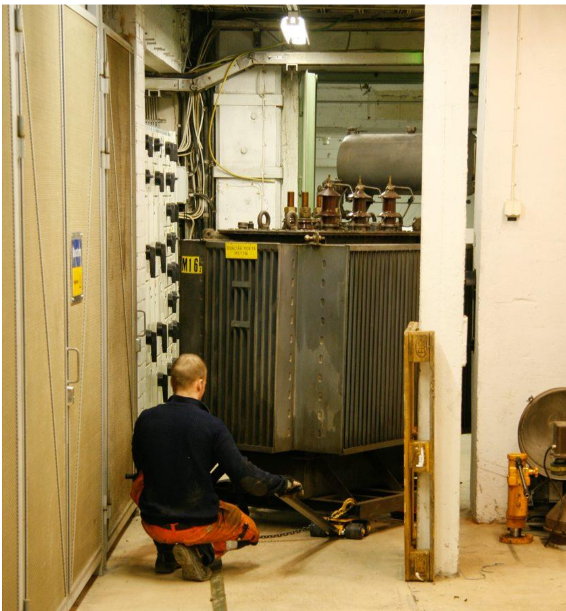
Kuva 15. Muuntajan haalauksista siirtorullien avulla. [27.]
