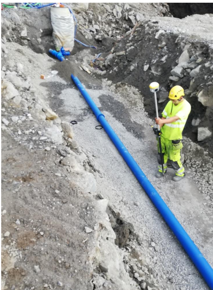
KUVA 12. Vesijohto kohteelle rakennettiin halkaisijaltaan 100 - 200 mm SG-valurautaputkesta. Lapiomies kartoittaa putken sijainnin GPS -mittasauvalla.
