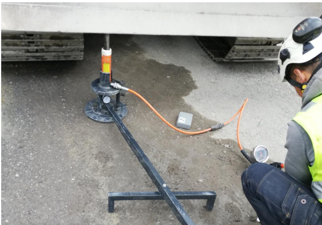
KUVA 2. Mittamies ottamassa levykuormituskoetta kantavasta kerroksesta yksikelloisella kuormituslaitteistolla.
