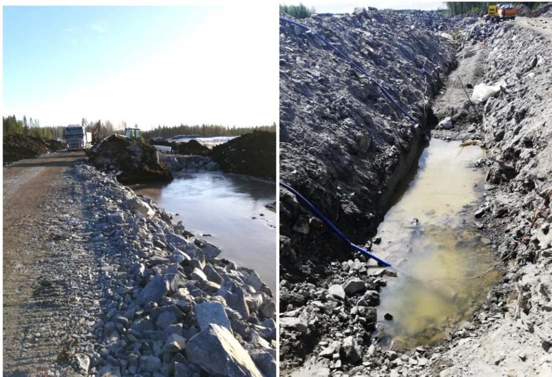
KUVA 5 JA 6. Vedenpinnan korkeus aiheutti haasteita koko työmaan keston ajan. Kuvat ovat samasta kohdasta, eri kuvaussuunnista. Kuva 5 helmikuulta ja kuva 6 heinäkuulta 2019.
