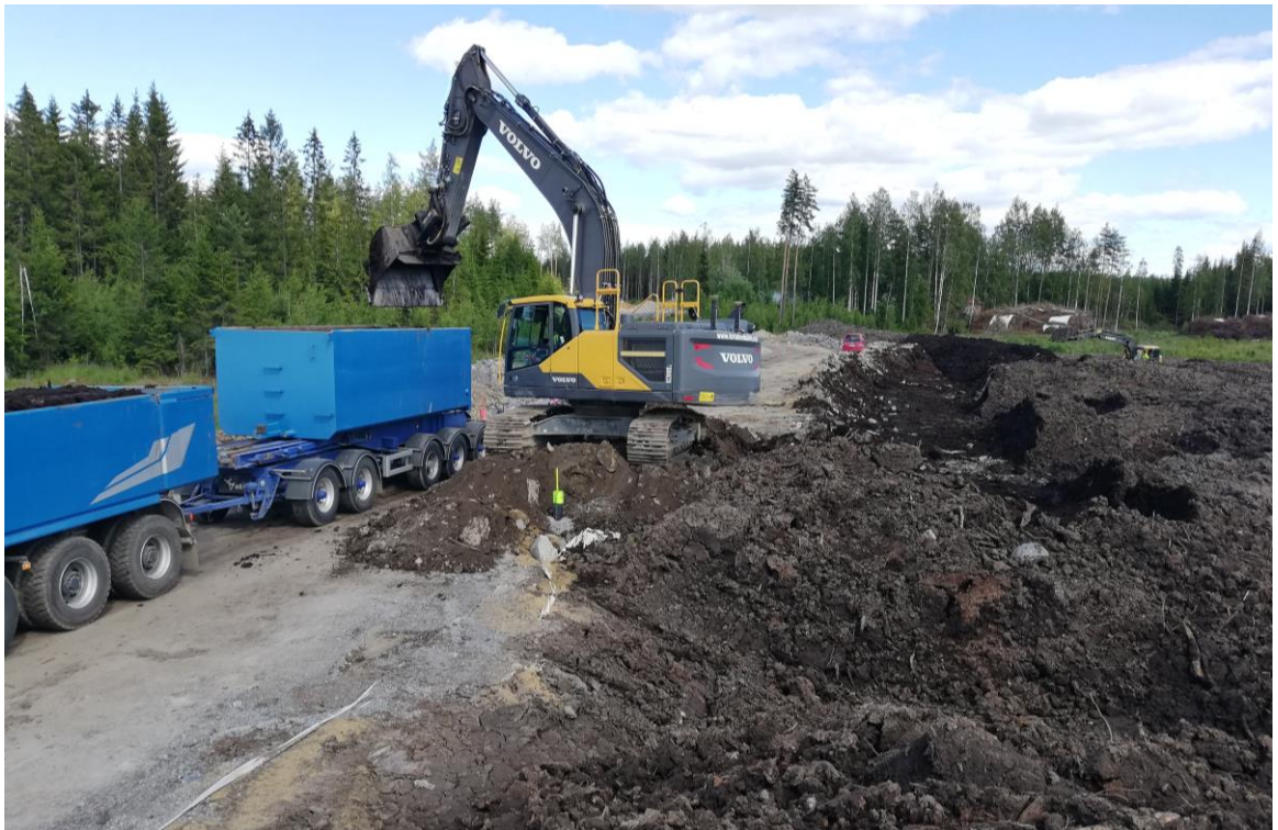
KUVA 10. Työmaalla aumatun turpeen lastausta poisajettavaksi.
