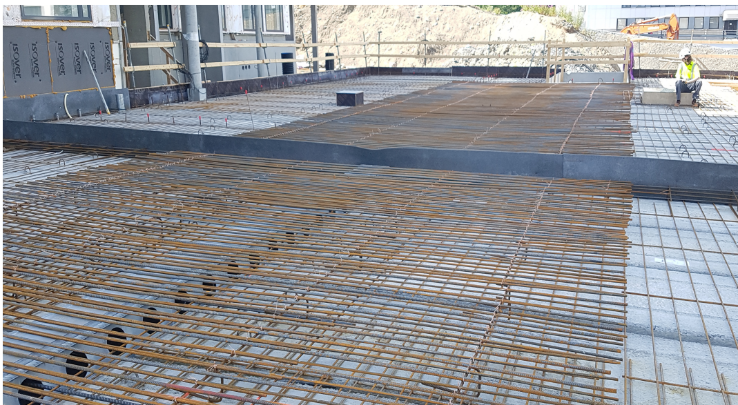
Kuva 9 Raudoitukset kuorilaataston päällä (Kuva: S.Aarnio)
