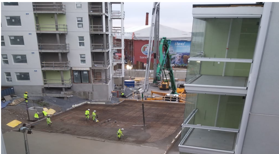
Kuva 6 Paikallavaletun holvin betonointityöt (Kuva: J.Ottman)
