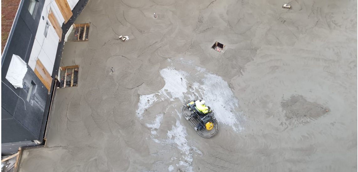
Kuva 16 Holvin hionta helikopterilla (Kuva J.Oksanen)
