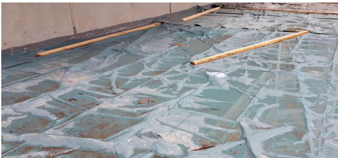
Kuva 7 Paikallavaletun holvin peittäminen (Kuva: J.Ottman)
