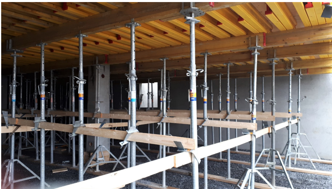
Kuva 4 Paikallavaletun holvin muotit ja tuenta (kuva J.Ottman)
