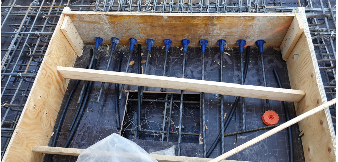
Kuva 14 Jälkijännitysvaijereiden päät laatikossa (Kuva: J.Oksanen)
