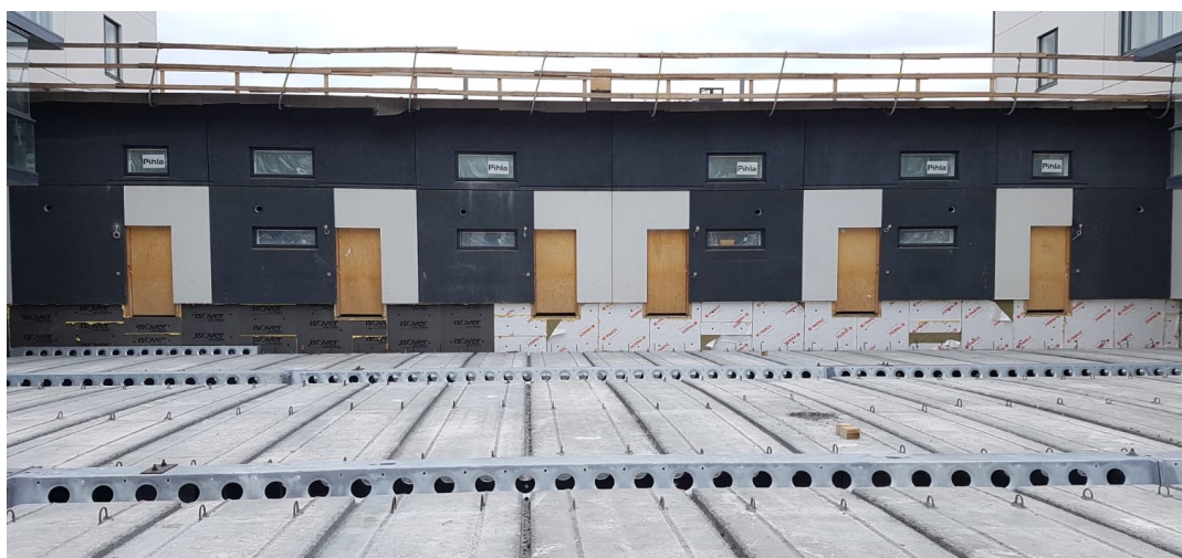
Kuva 8 Kuorilaatasto ennen valua (Kuva: S.Aarnio)
