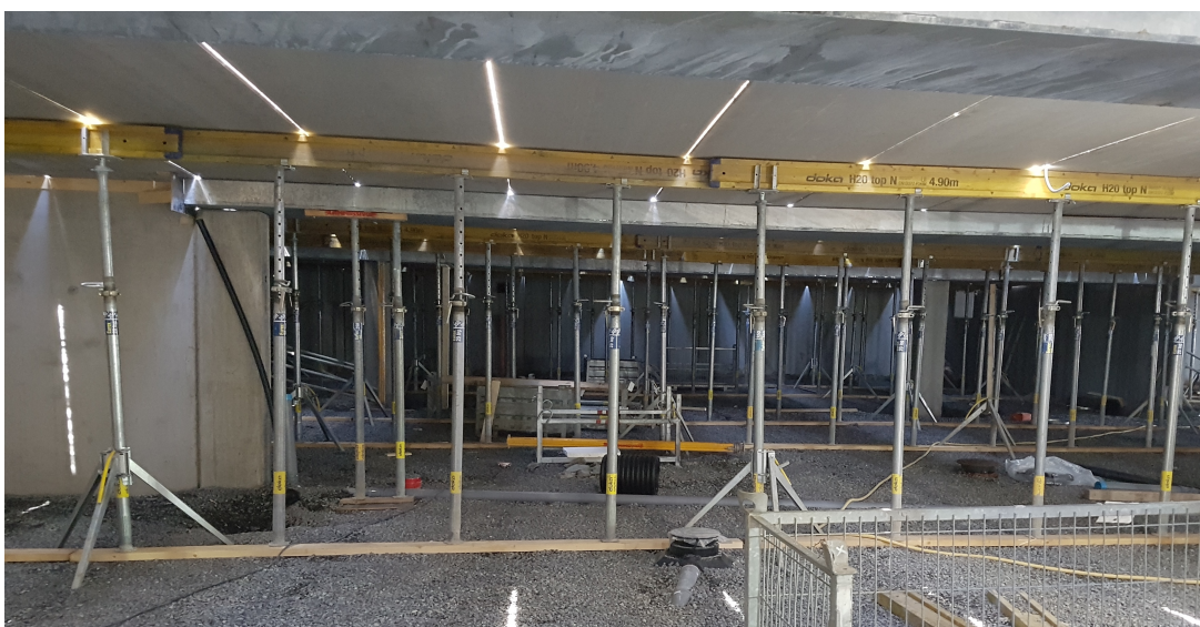
Kuva 10 Kuorilaataston väliaikainen tuenta (Kuva: S.Aarnio)
