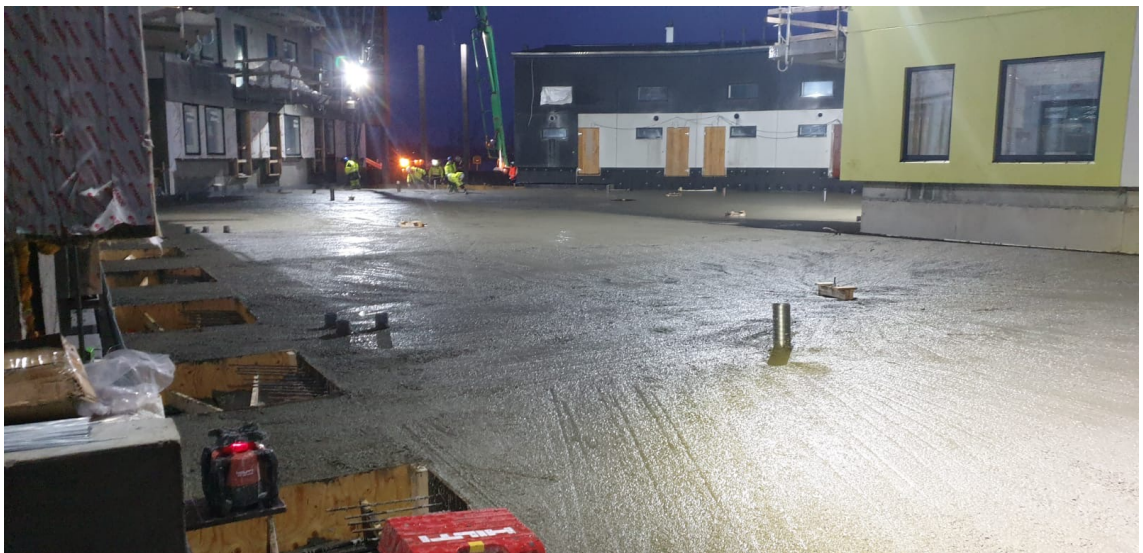
Kuva 15 Jälkijännitetyn holvin valu (Kuva: J.Oksanen)
