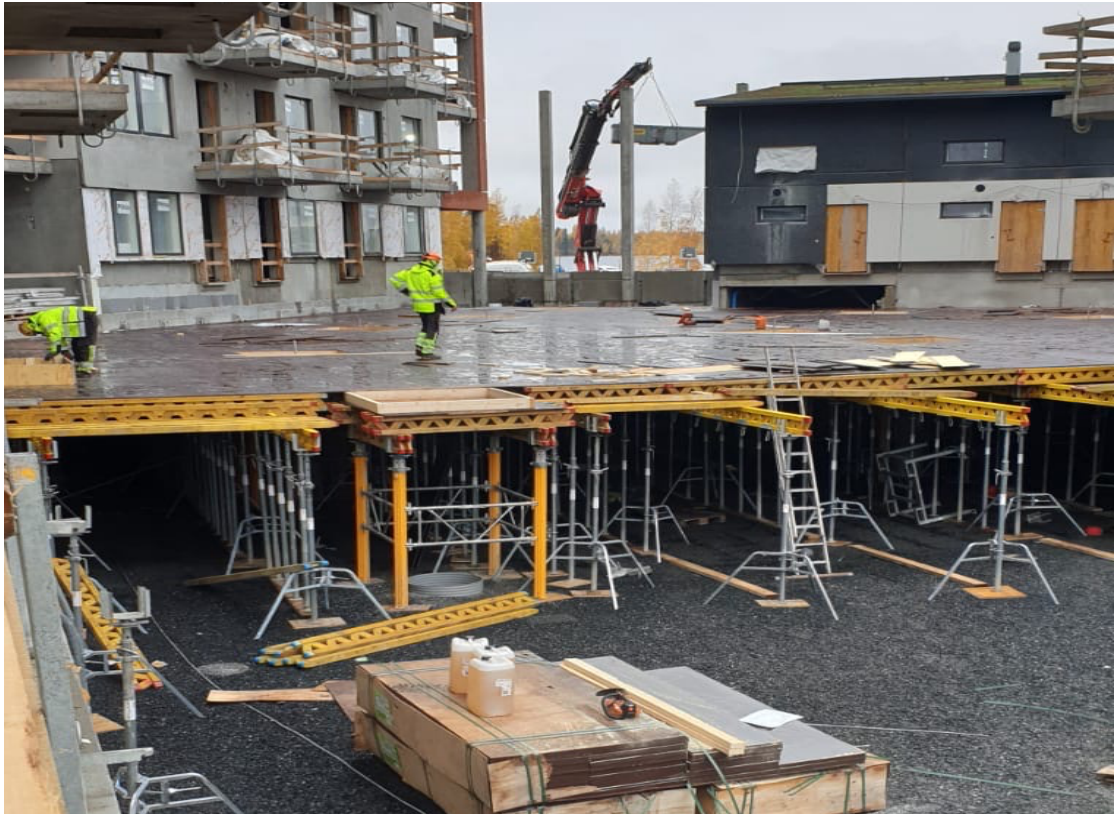
Kuva 12 Holvin muottikalustoa (Kuva J.Oksanen)
