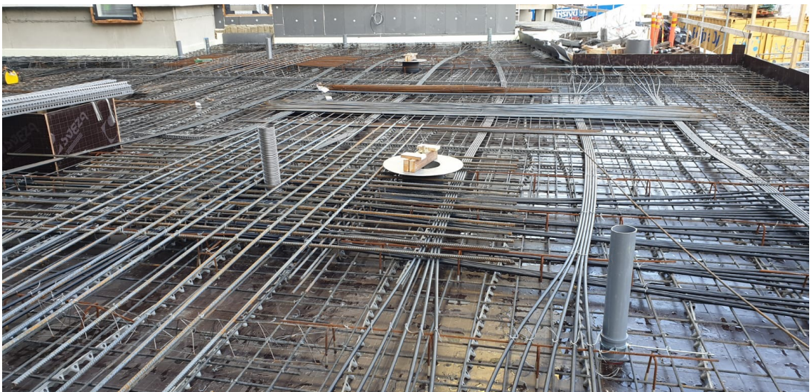
Kuva 13 Raudoitukset ja jälkijännitysvaijerit (Kuva: J.Oksanen)
