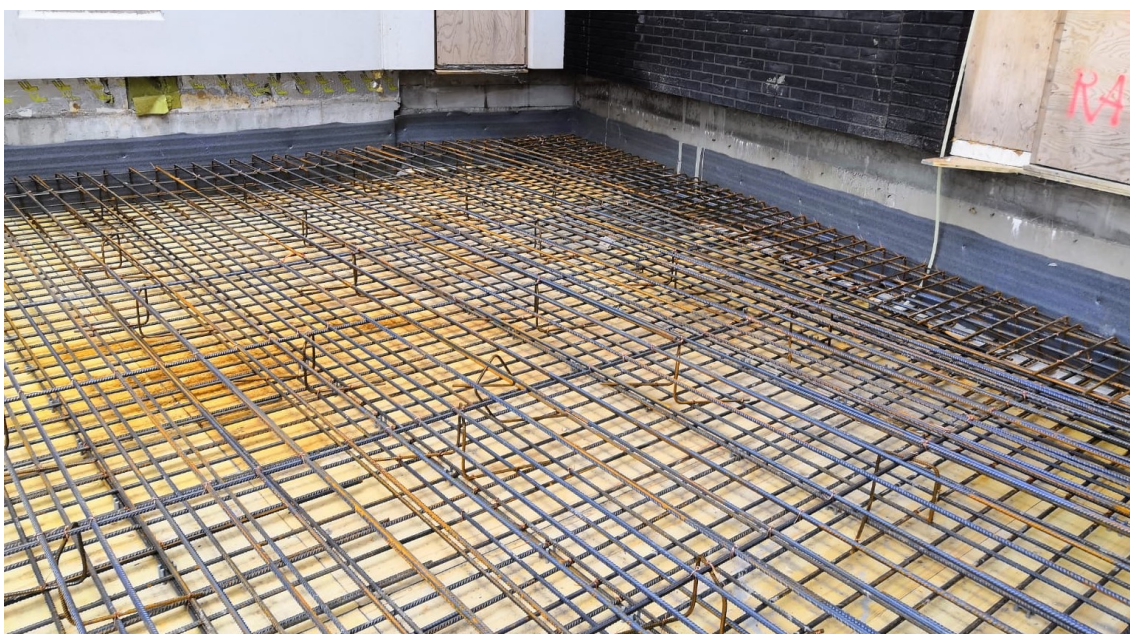
Kuva 5 Paikallavaletun holvin raudoitusta ja alla muotti (kuva J.Ottman)
