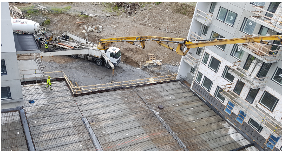
Kuva 11 Kuorilaatastojen holvivalu (Kuva: S.Aarnio)
