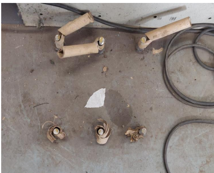
KUVA 3. Betonivaluun upotetut kierretangot (Vahterinmäki 2020)
