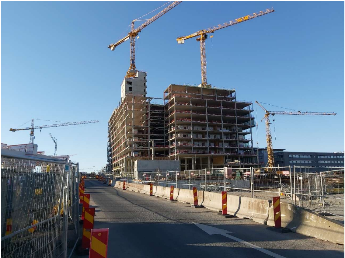
Kuva 1. Platinan työmaa rakennettuna 14 tasolle. 8.4.2020.
