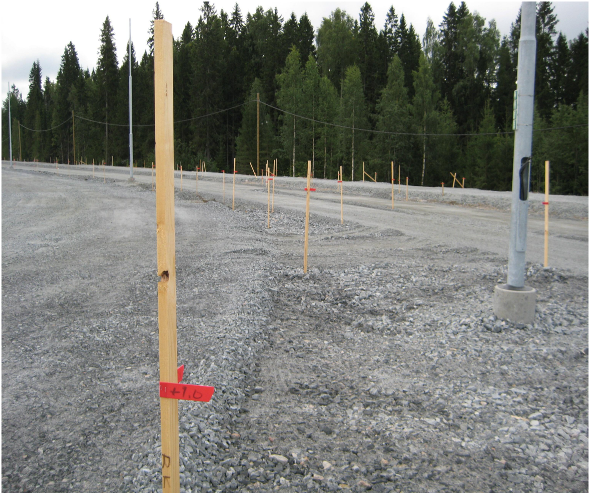
Kuva 2. Kantavan kerroksen paalutusta.
