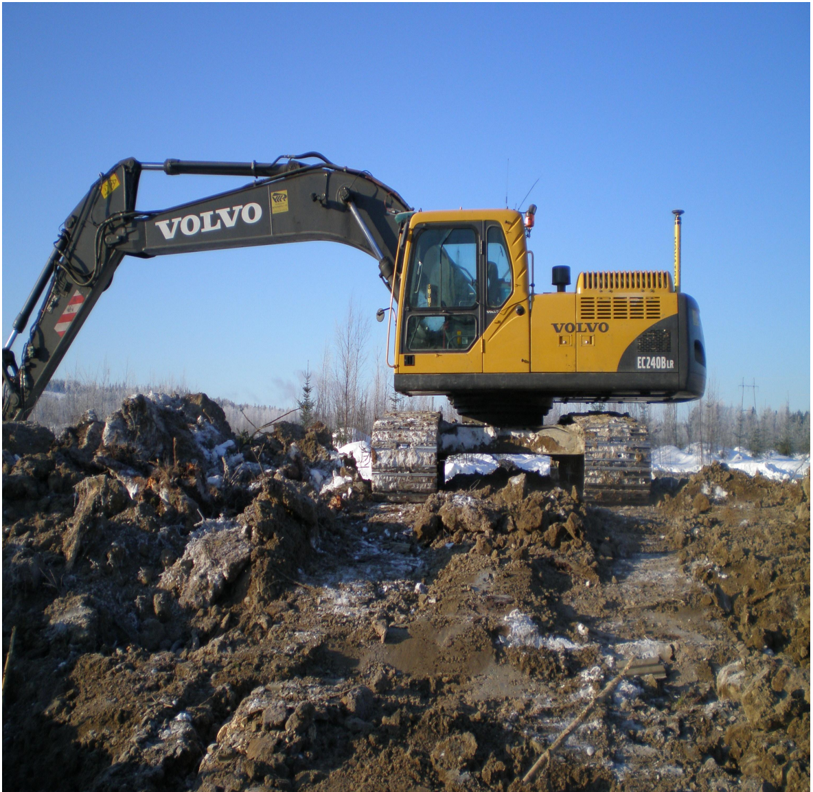
Kuva 7. Työkoneohjaus käytössä kaivukoneessa.
