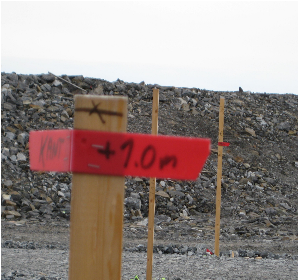
Kuva 1. Kantavan kerroksen korkeus merkitty ”metrin ajolla”.
