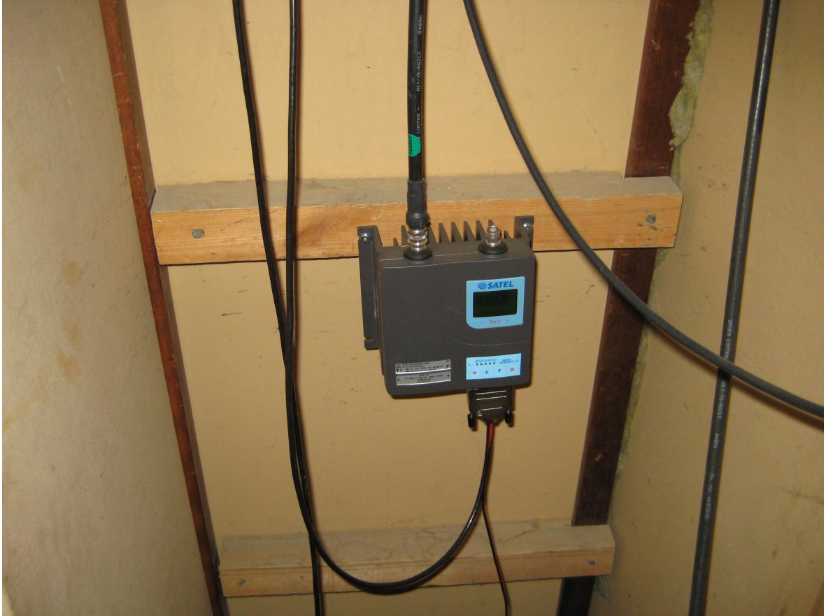
Kuva 12. Radiomodeemi ja vahvistin korjaussignaalia varten.
