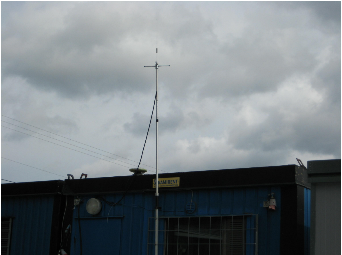
Kuva 10. Tukiaseman GPS-antenni ja radioantenni.
