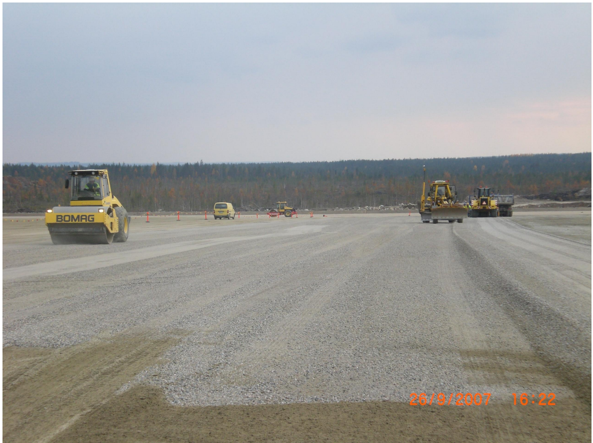
Kuva 9. Kantavan kerroksen levitystä takymetriohjatuilla tiehöyllillä
