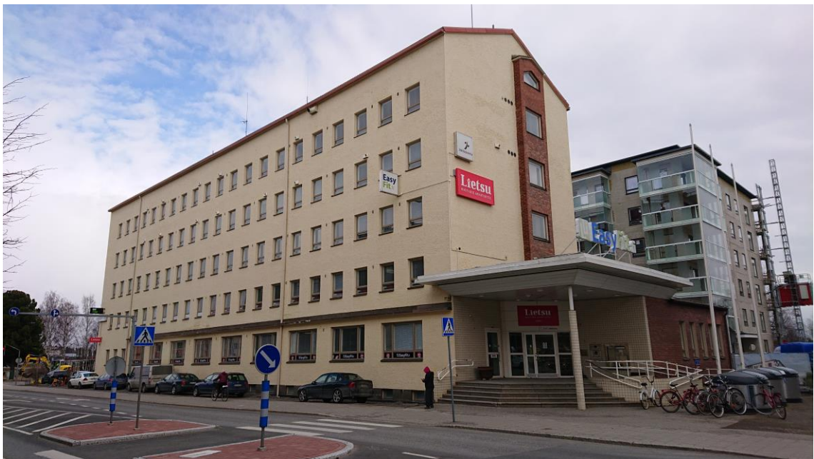
Kuva 2. Huoneistohotelli Lietsu sijaitsee kiinteistön kahdessa ylimmässä kerroksessa (Kuva: Tuukka Mäkelä).
