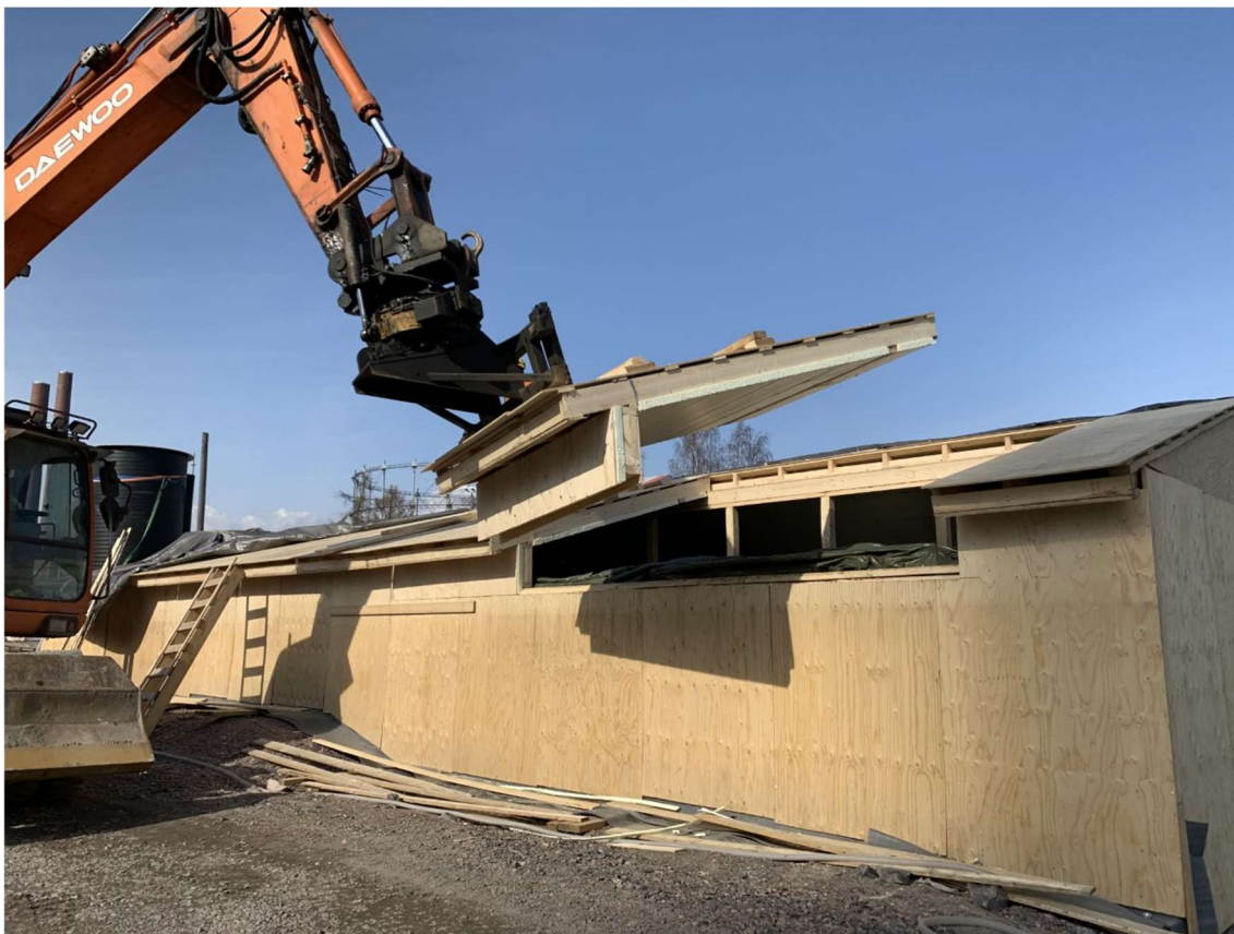
Kuva 6. Suodatinrakennuksen katon nosto.
