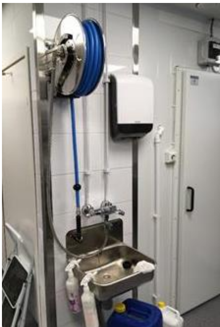
Kuva 29. Vaahtopesulaitteen toteutus rakennuskohteessa.
