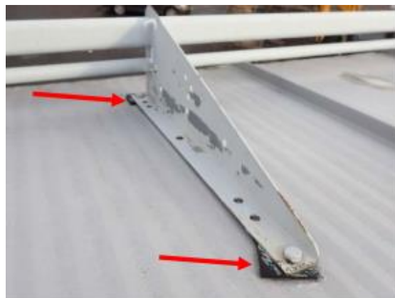
Kuva 13. Lumiesteet on kiinnitetty vesikatteen lävitse ja kiinnityskohdat on tiivistetty tiivistepaloilla.
