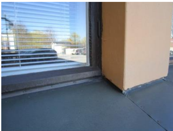
Kuva 16. Ikkunoiden vesipellitykset ovat hyväkuntoisia.
