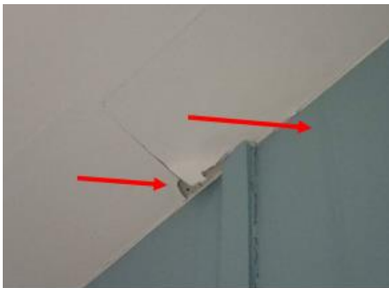
Kuva 14. Kosteusjäljet katossa ja valumajäljet seinässä. Kuva 15. Halkeillut laastisauma.
