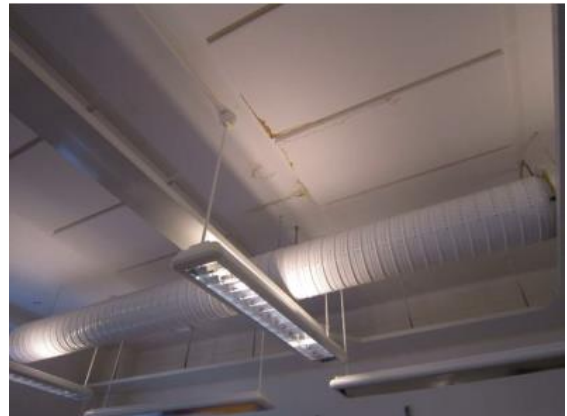
Kuva 19. Kosteusvauriojälkiä katossa.
