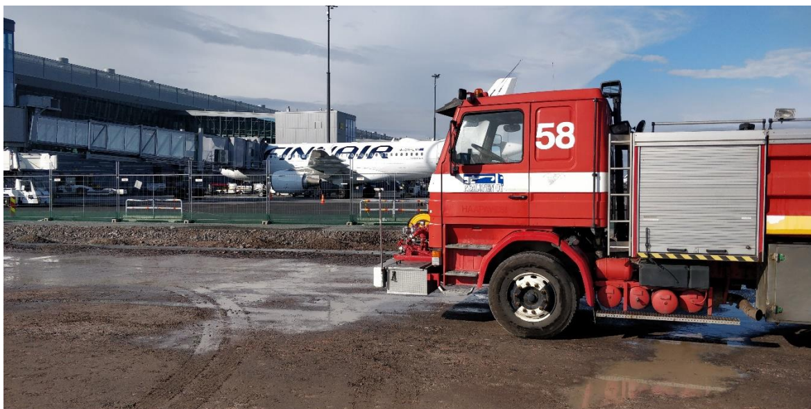
Kuva 1. Pölynsidontaan hankittu paloauto työmaalla
