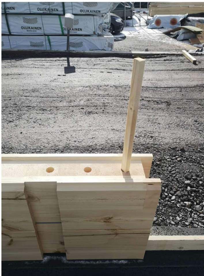
Kuva 13. Toinen (2.) hirsivarvi tapitetaan rakennuksen sisältä katsottuna oikeanpuoleiseen tappireikään.
