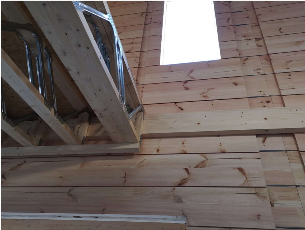
Kuva 19. Posi-palkit asennetaan hirsiseinään kiinnitettävien kannatinpuuiden varaan.
