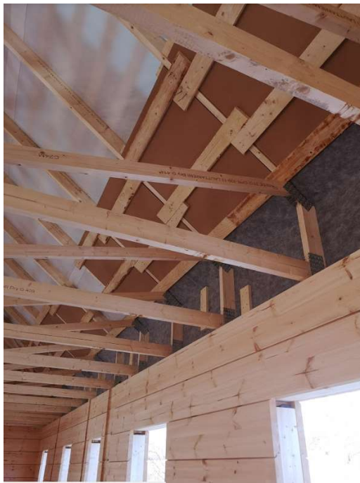
Kuva 21. Kattoristikoihin kiinnitetään tuulenojaimet.
