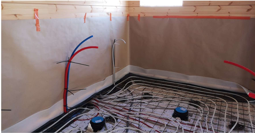
Kuva 27. Hirsiseinä suojataan valuroiskeilta.
