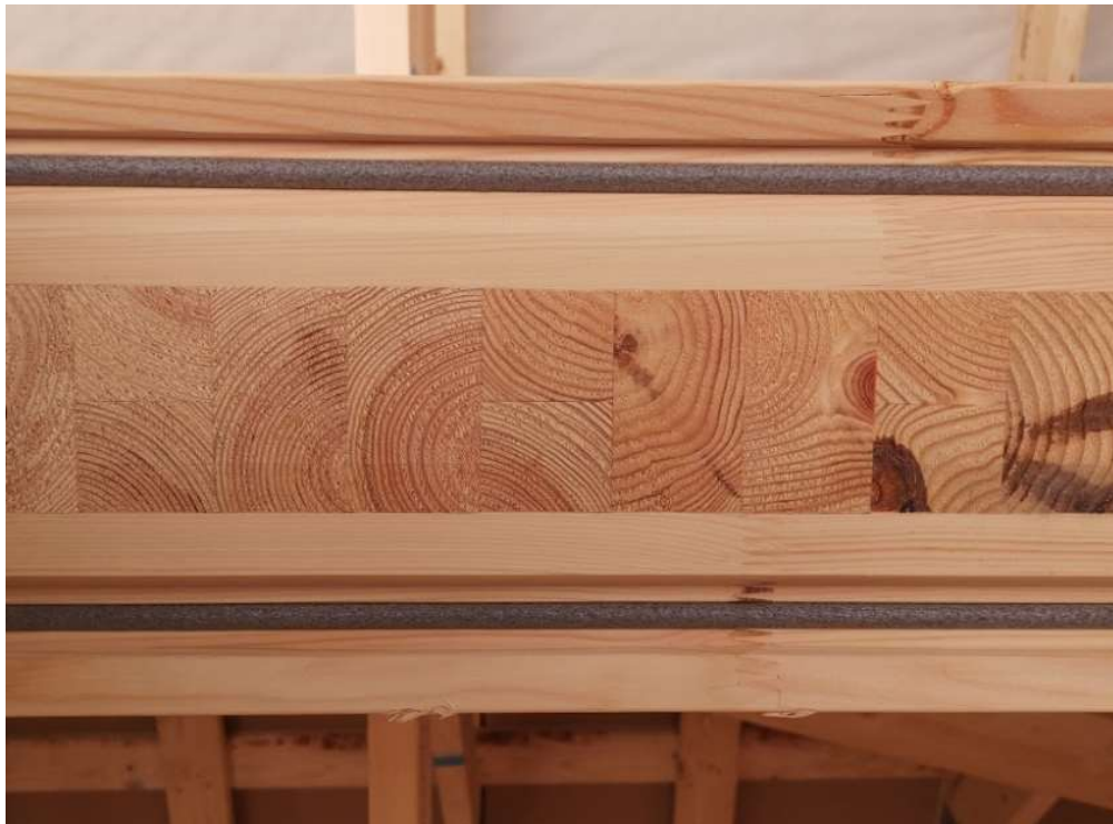
Kuva 11. Jokaisen hirren alareunassa on tehdasasenteiset solumuovinauhat.
