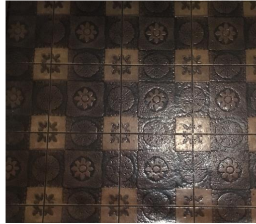
Kuva 8. Alkuperäinen kodinhoitohuoneen lattia. (Sonja Holappa, 2019)
