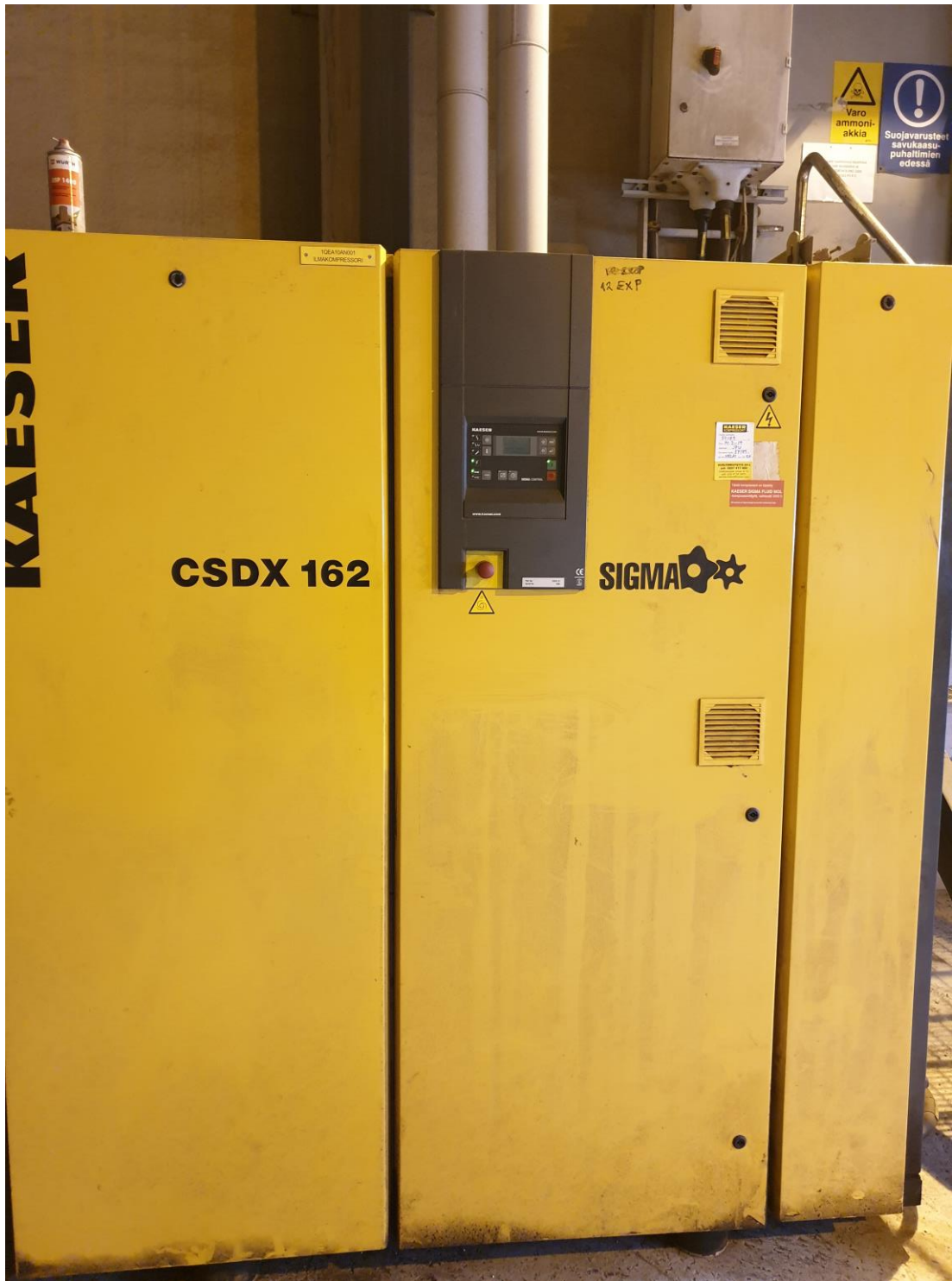
Kuva 3. Savukaasupuhallin huoneessa sijaitseva kattilan kompressor.
