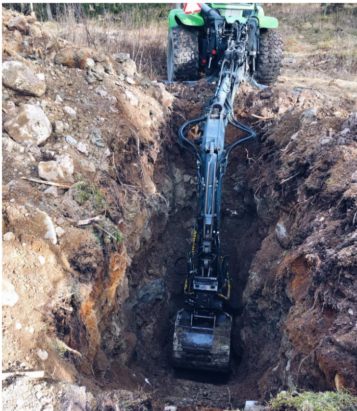
Kuva 9. Testikaivanto, Anniina Nurmi
