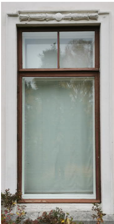
Kuva 97 Eteläpuolen 1. kerroksen ikkuna. Arkkitehtitoimisto Hanna Lyytinen Oy
