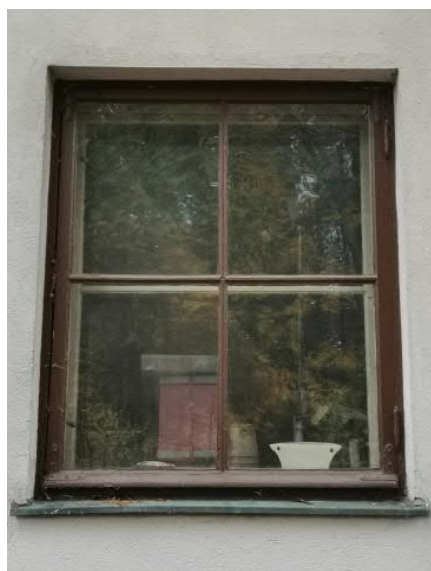
Kuva 100 Autotallin ikkuna. Arkkitehtitoimisto Hanna Lyytinen Oy
