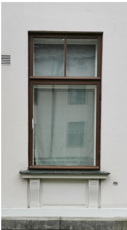
Kuva 95 Pohjoispuolen 1. kerroksen ikkuna. Arkkitehtitoimisto Hanna Lyytinen Oy
