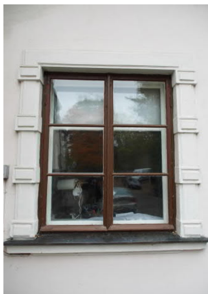
Kuva 98 Taloussiiven ikkuna. Arkkitehtitoimisto Hanna Lyytinen Oy
