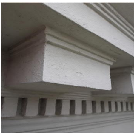
Kuva 85 Räystään kipsikoristeet. Arkkitehtitoimisto Hanna Lyytinen Oy
