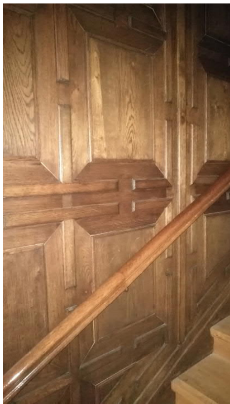
Kuva 106 Portaikon tammipanelointi. Arkkitehtitoimisto Hanna Lyytinen Oy
