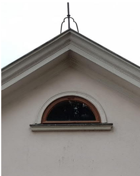
Kuva 101 Autotallin ikkuna. Arkkitehtitoimisto Hanna Lyytinen Oy
