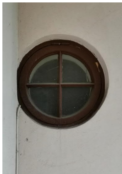
Kuva 102 Eteläpuolen varaston ikkuna. Arkkitehtitoimisto Hanna Lyytinen Oy
