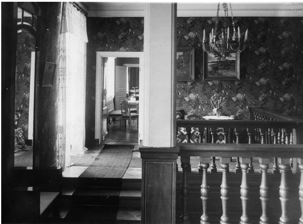
Kuva 57 Yläkerran aula vuonna 1925. Pyynikinlinnan arkisto
