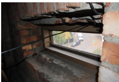
Kuva 127 Ikkuna sisäpuolelta. Arkkitehtitoimisto Hanna Lyytinen Oy
