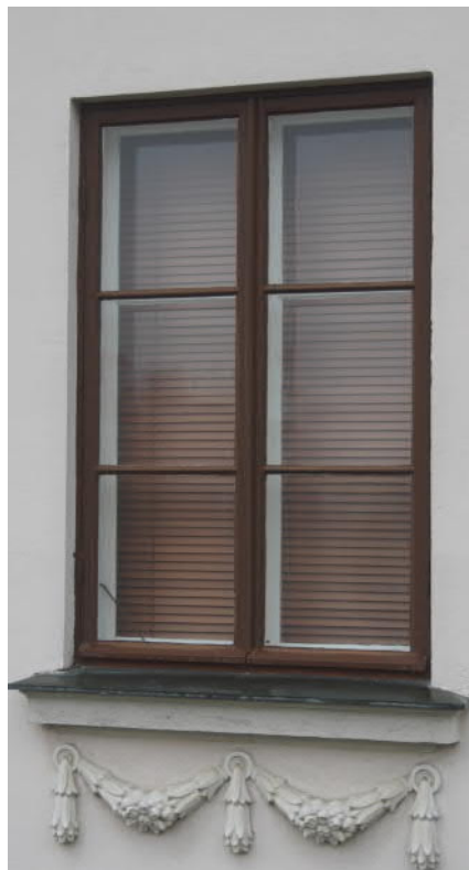
Kuva 96 Pohjoispuolen 2. kerroksen ikkuna. Arkkitehtitoimisto Hanna Lyytinen Oy
