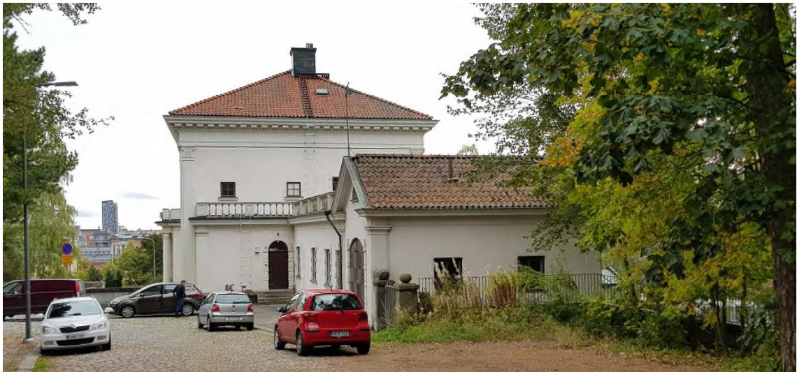
Kuva 68 Julkisivu länteen vuonna 2019. Arkkitehtitoimisto Hanna Lyytinen Oy
