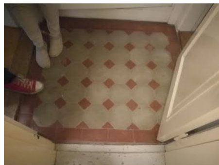
Kuva 110 Välikön klinkkerilaatta. Arkkitehtitoimisto Hanna Lyytinen Oy
