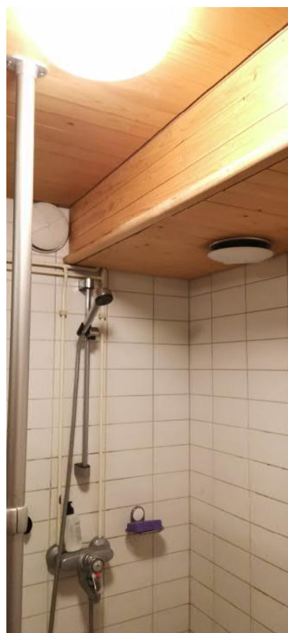
Kuva 121 Pesuhuone. Arkkitehtitoimisto Hanna Lyytinen Oy
