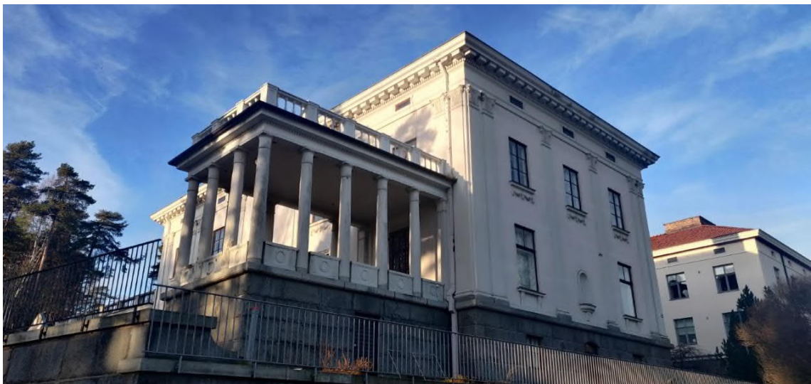
Kuva 69 Julkisivu itään vuonna 2020. Jessica Sivula
