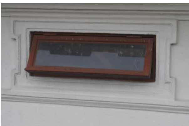
Kuva 103 Ullakon ikkuna. Arkkitehtitoimisto Hanna Lyytinen Oy
