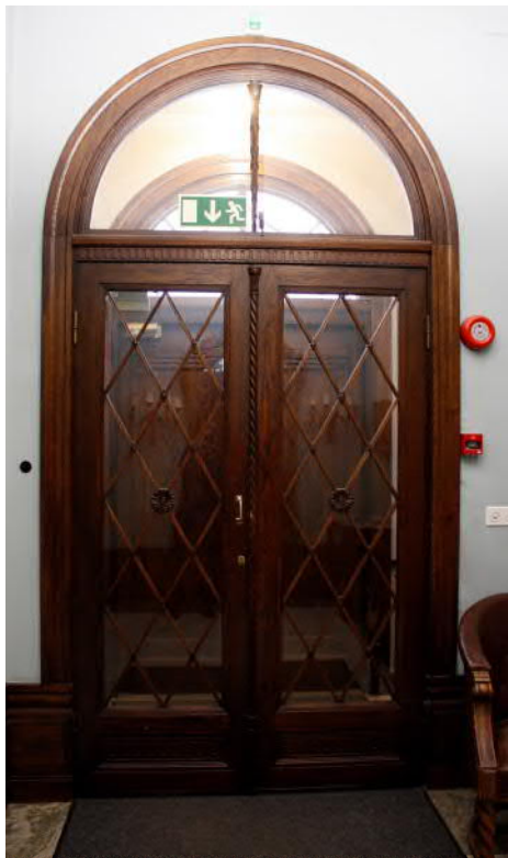
Kuva 87 Tuulikaapin sisäövet. Arkkitehtitoimisto Hanna Lyytinen Oy
