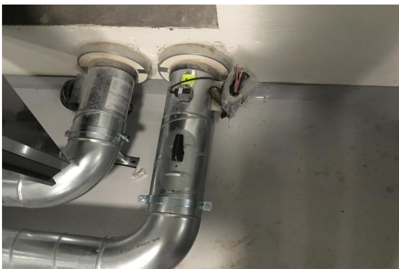
Kuva 8. Palopeltien oikeaoppinen asennus ja tiivistystapa. (Kuva T2H Rakennus Oy:n työmaalta)
