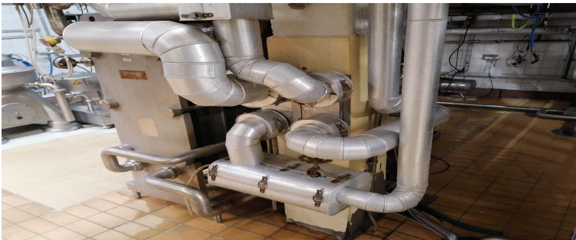
KUVA 9. Maitopastöörin levylämmönsiirtimet
