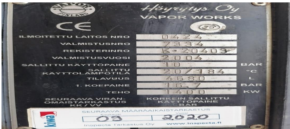
KUVA 2. Kattilan tyyppikilpi
