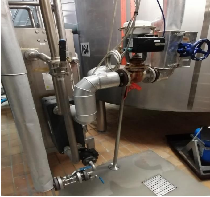
KUVA 15. Piimäpastöörin levylämmönsiirtimet
