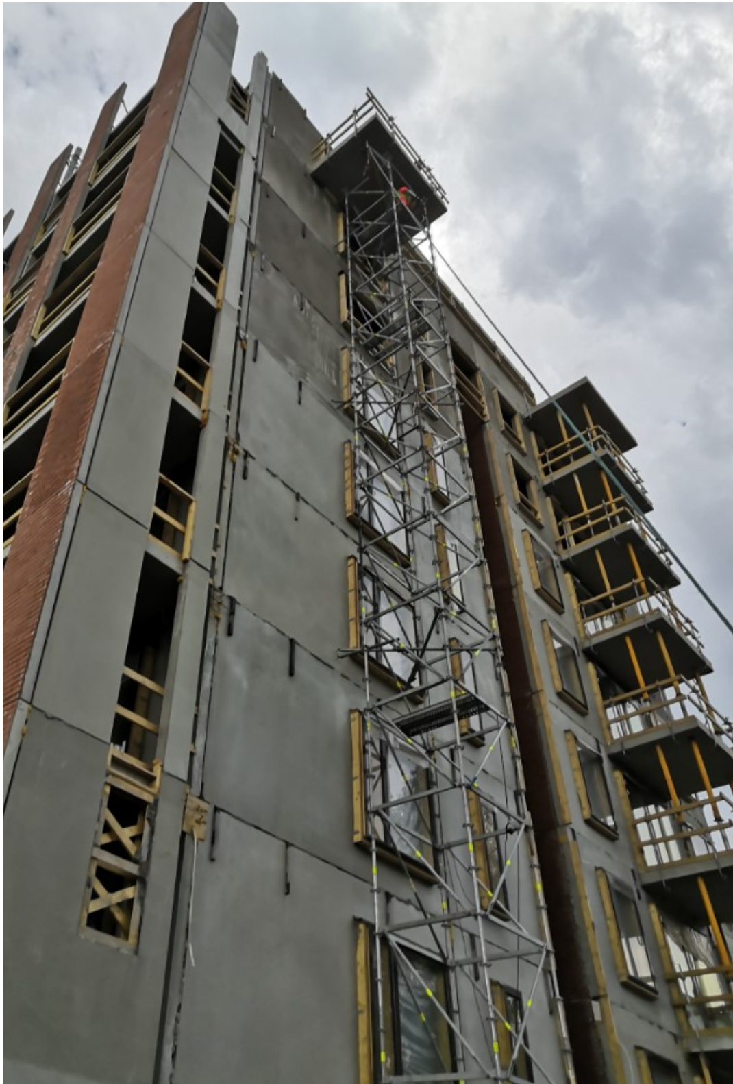
Kuvio 16. Vasemmalla tukitornilla tuettu laatta ja oikealla MultiProp-tuennalla tuettu parvekelinja (JVA Pellonreuna valokuvat 2019)
