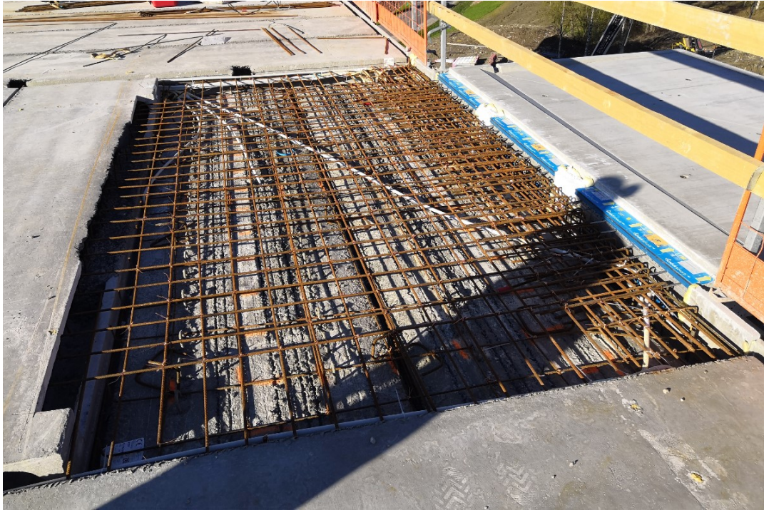
Kuvio 15. Raudoitettu kuorilaatta (JVA Pellonreuna valokuvat 2019)
