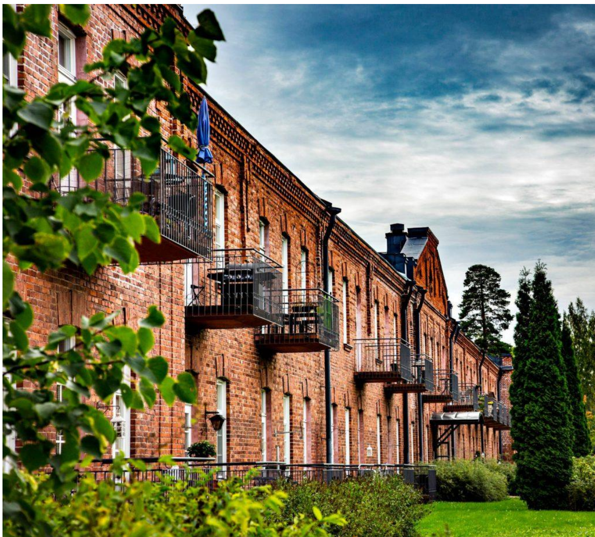
Kuva 16. Kouvolan Korian kasarmialueen kunnostettu rakennus (Heikkilä 2018-11-10)
