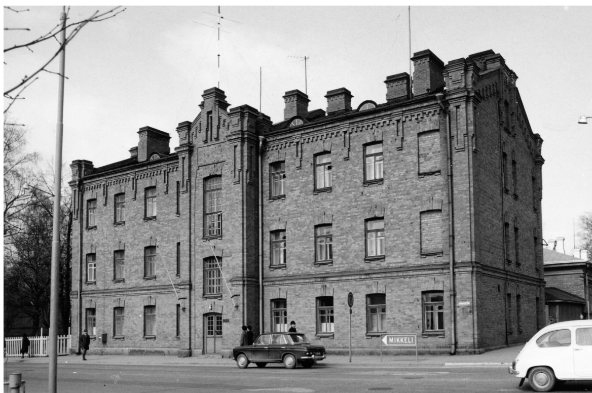
Kuva 7. Rakennuksen A37 julkisivu Tulliportinkadulle 1960–1970-luvulla (Sotamuseo)
