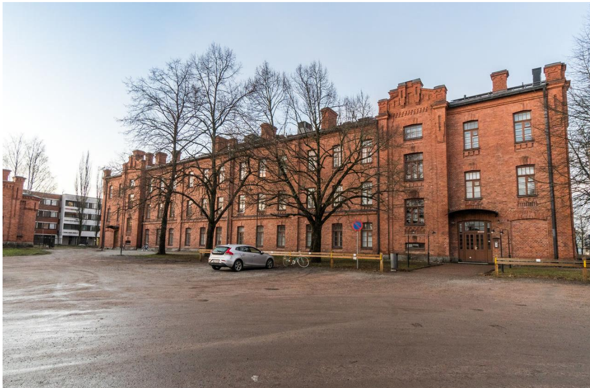
Kuva 17. 2017 peruskorjattu Asunto Oy Hämeenlinnan Karoliina, Hämeenlinnan Myllymäki (Etuovi.com)
