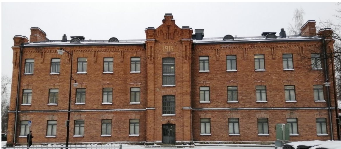
Kuva 13. Rakennuksen F 36 julkisivu Tulliportinkadulle
