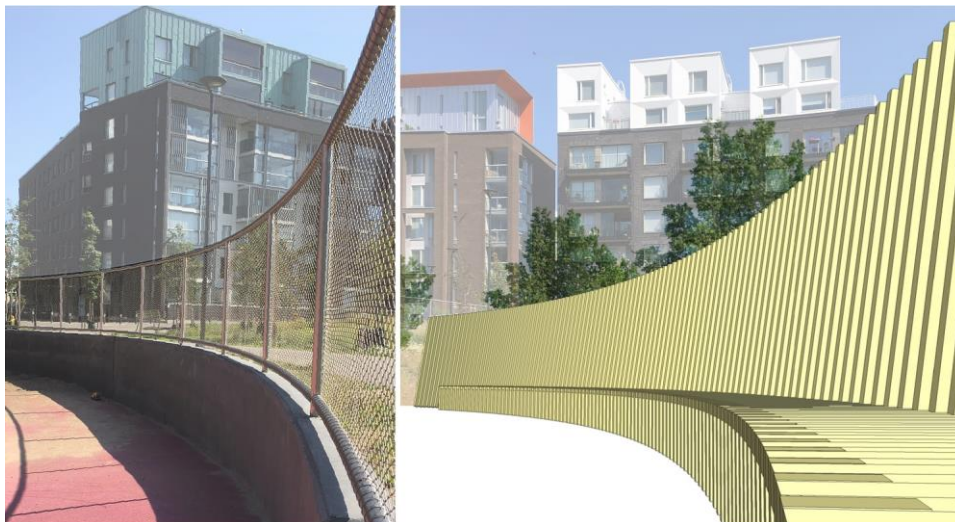
Kuva 24. Vasemmalla vastaavanlainen rakenne kuin laskennassa käytetty, mutta teräsverkko on korkeampi ja betonireunus on osittain leveämpi. Oikealla puuaidan havainnekuva. (Koivunen, 2019)
