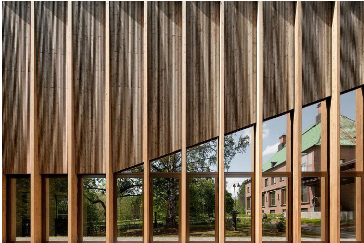
Kuva 55. Kuvassa Göstan paviljongin julkisivun pystysuuntaista linjaa. Valokuva Pegro Pegenaute.
