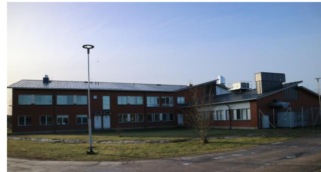
Kuva 44. Oleva yläkoulurakennus koillisen suunnasta kuvattuna.
