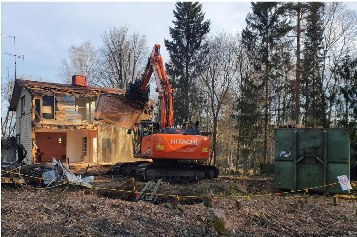
Kuvio 5. Purkavaa lisärakentamista. Vanhan pientalon purkutyöt käynnissä Hirsikalliontiellä Laaksoahdessa. Tilalle rakennetaan uusi pientalo.
