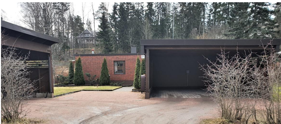
Kuvio 30. Hirsitie 27. 1970-luvulla rakennetun paritalon etupiha on varattu pysäköinnille. Sisäänkäynnin edusta ja autokatoksen alue on kivetty, mutta suurin osa etupihasta on jätetty pinnoittamatta.
