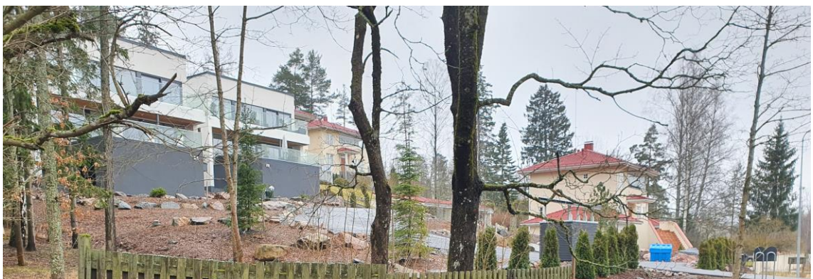
Kuvio 8. Rinteeseen rakennettuja erillistaloja. Maastoa on jouduttu muokkaamaan voimakkaasti rakennustöiden ja käyttökelpoisten ajoyhteyksien toteuttamiseksi. Rakennusmassa on suurta, vaikka alueen rakennustehokkuusluku on vain 0.2.
