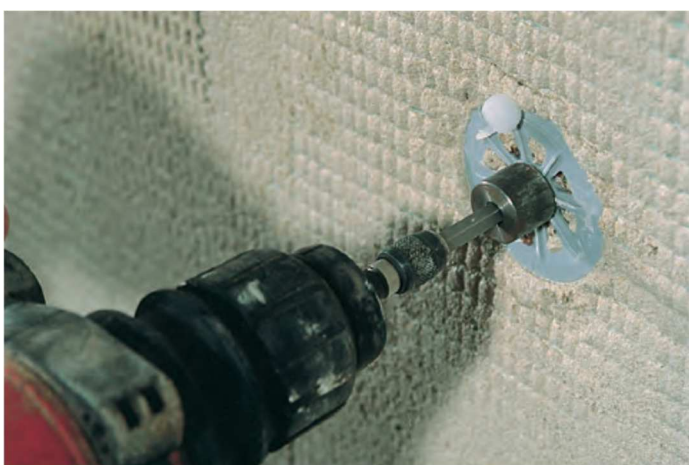
Kuva 54. Mekaaninen kiinnike asennetaan verkotuslaastikerroksen läpi. Kuva: Anonyymi materiaalivalmistaja 2 menetelmäesite, ajankohta tuntematon.
