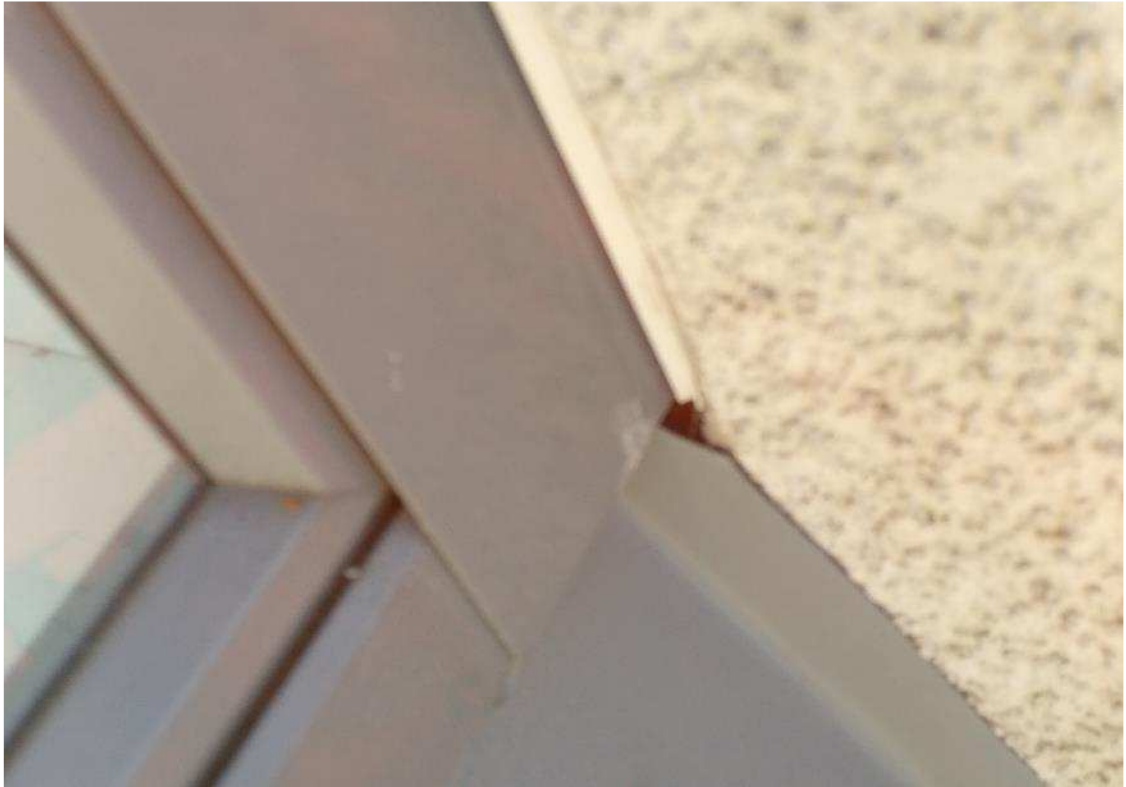
Kuva 12. Vesipeltiliittymä kuvattu pystysuunnasta alaspäin. Kuva: Matti Eronen 2018.
