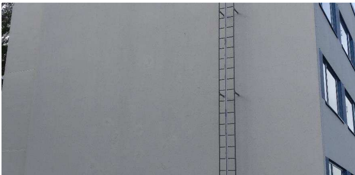
Kuva 68. Paikkakorjattu ja huoltomaalattu julkisivu. Kuva: Matti Eronen 2019
