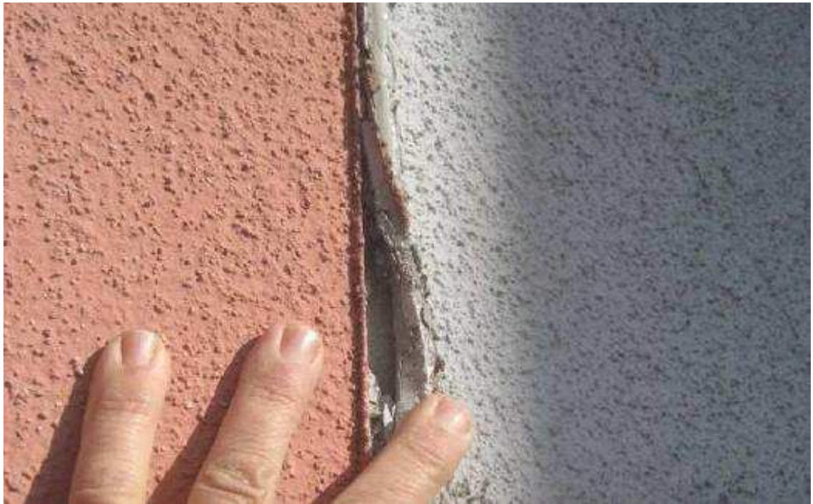
Kuva 22. Tehostekohdan rajausta on tehty elastisella liimamassalla. Kuva: Juha Räisänen 2016.
