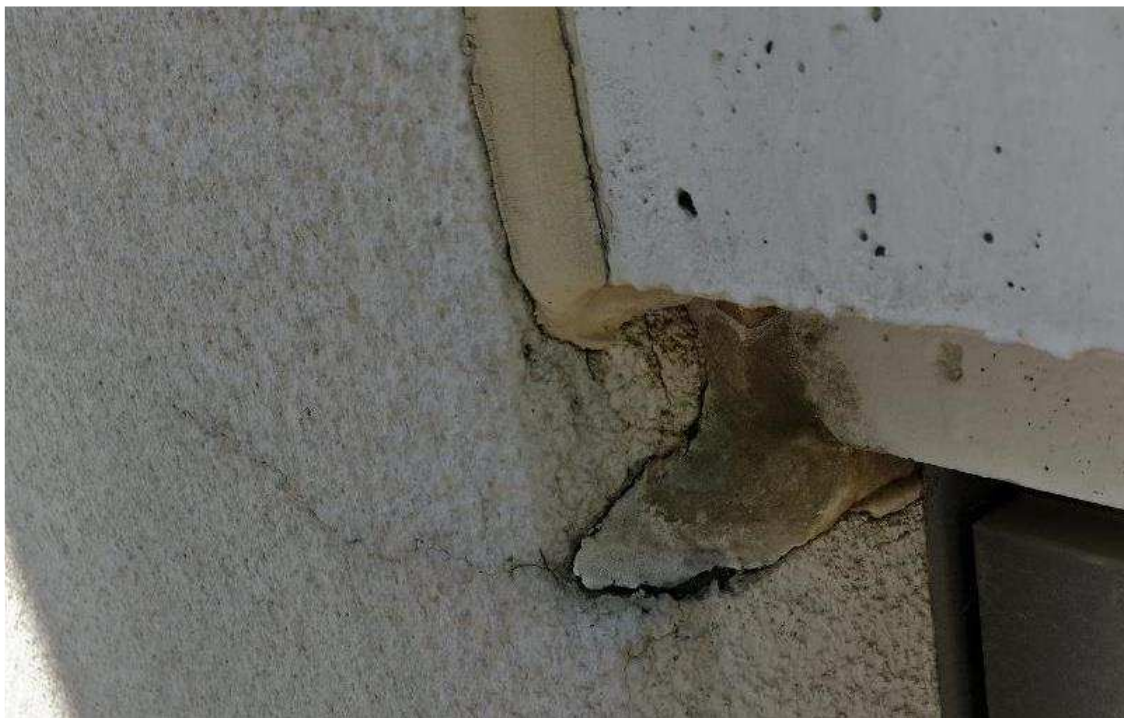
Kuva 19. Parvekelaatan ja eristerappauksen liittymässä hylly, sisäänvedetty parveke. Kuva: Matti Eronen 2018.
