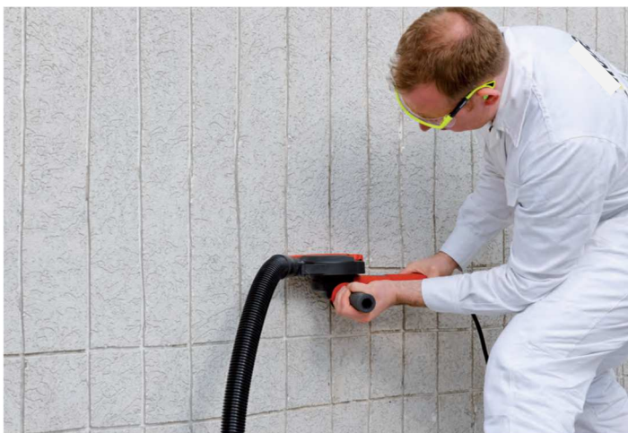
Kuva 53. Uritustyö käynnissä. Kuva: Anonyymi materiaalivalmistaja 2 menetelmäesite, ajankohta tuntematon.
