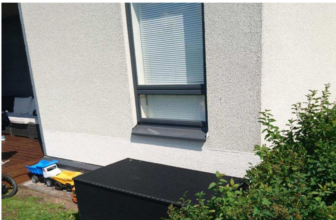
Kuva 63. Ohutrappaus korjattu sokkeliliittymän kohdalta. Kuva: Juha Räisänen 2019.
