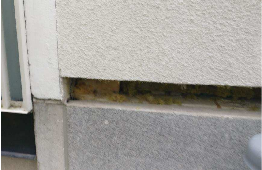
Kuva 8. Sokkeliliittymä avattu ohutrappausjärjestelmällä toteutetussa uudiskohteessa. Kuva: Matti Eronen 2018.
